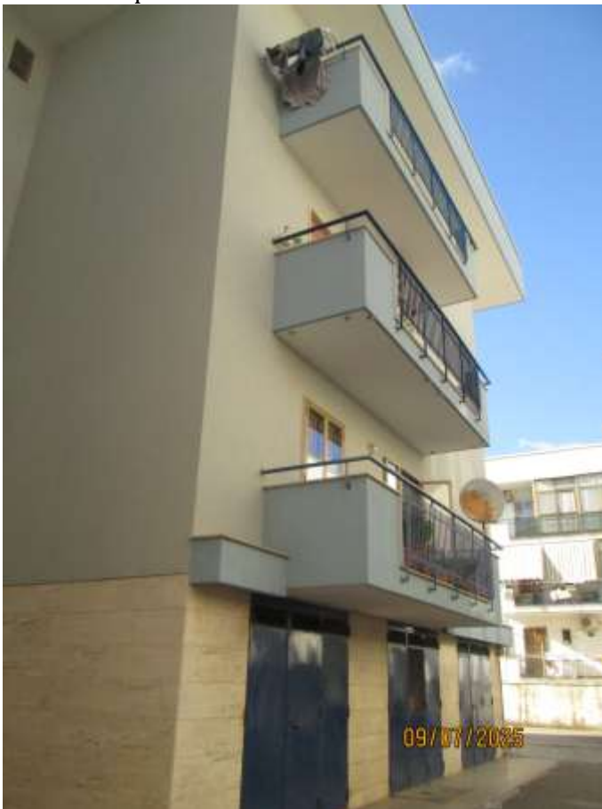
Prospetti Sud ed Ovest del fabbricato condominiale
