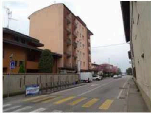
Vista Condominio da via Patrioti
