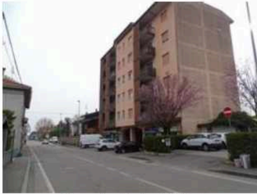
Vista condominio da via Patrioti
