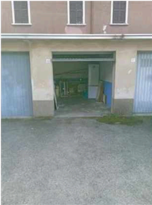
vista interna autorimessa
