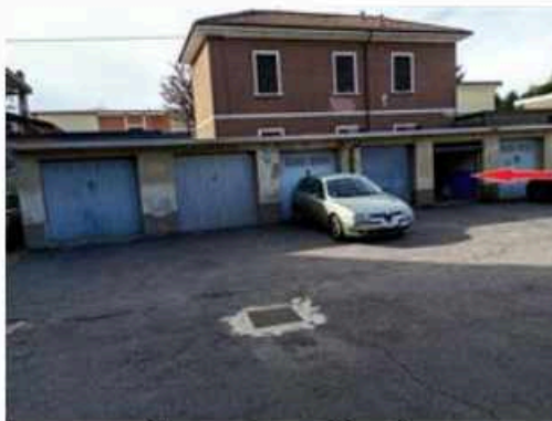
Vista autorimessa dal cortile
