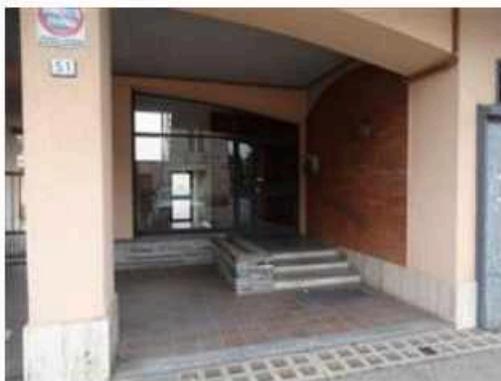
Vista ingresso condominio da via Patrioti
