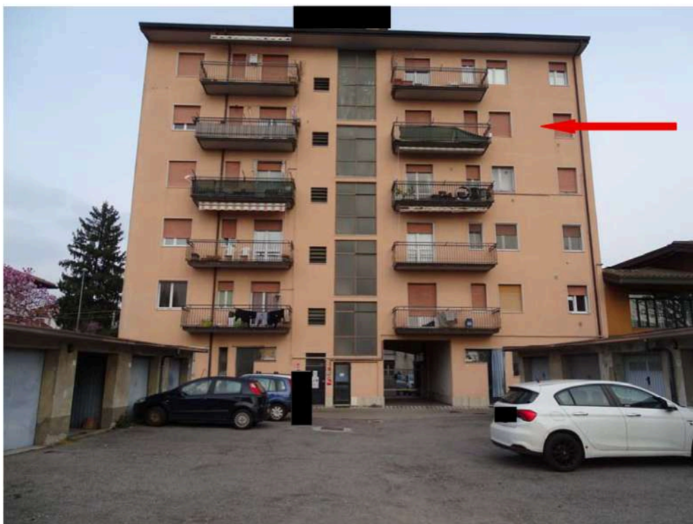
Vista fabbricato interno cortile e posizione appartamento
