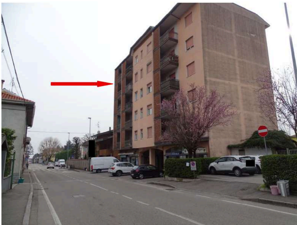
Vista fabbricato da via dei patrioti e posizione appartamento
