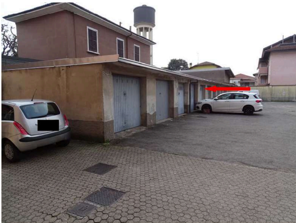
Vista cortile posizione autorimessa
