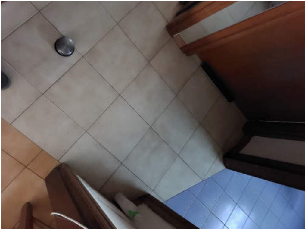
FOTO 19 Vista interna P4 – Disimpegno zona notte
