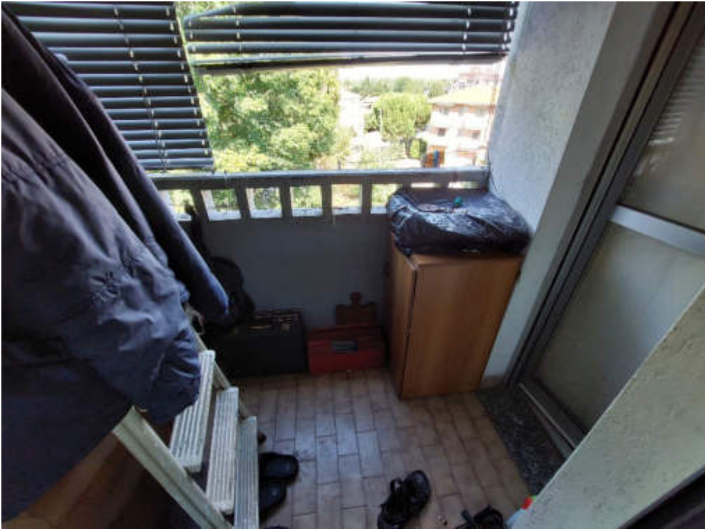
FOTO 13 Vista esterna P4 – Balcone nord-est
