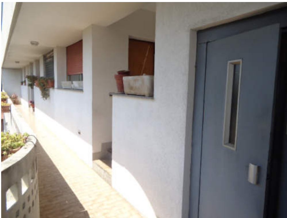
FOTO 7 Vista Esterna P4 – Fronte sud-ovest su ballatoio comune
