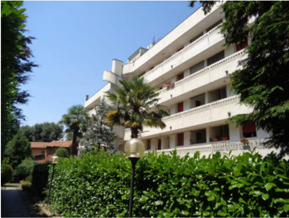
FOTO 3 Vista esterna – Fronte fabbricato (sud-ovest) su cortile comune
