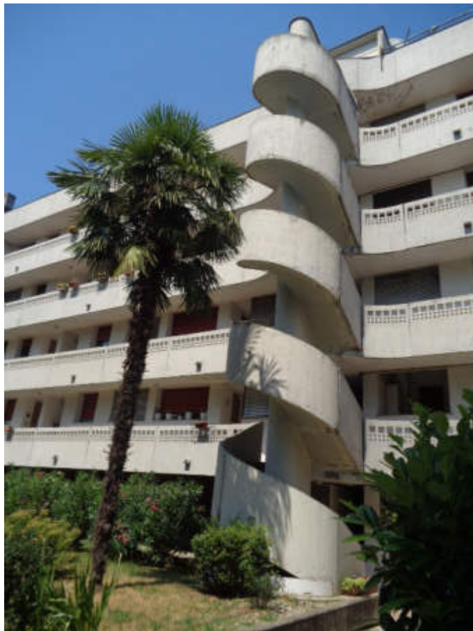
FOTO 4 Vista esterna – Accesso al vano scala comune
