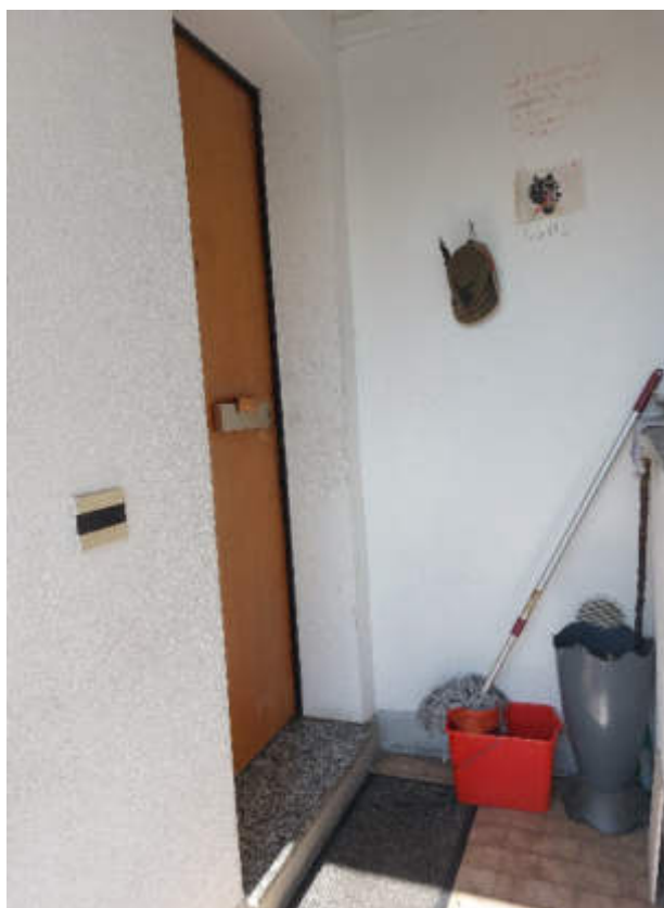
FOTO 6 Vista Esterna P4 – Ingresso da ballatoio comune
