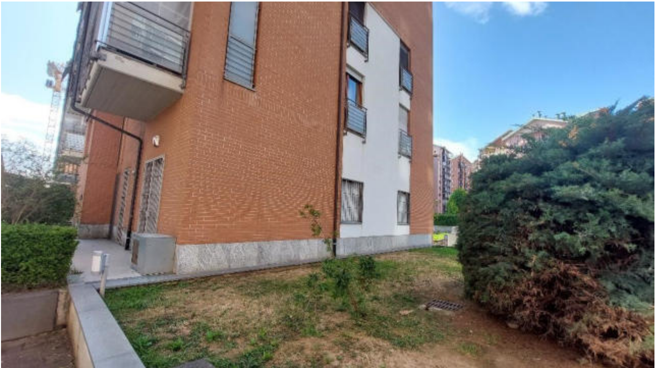
Vista del prospetto ovest dall'area pubblica.
