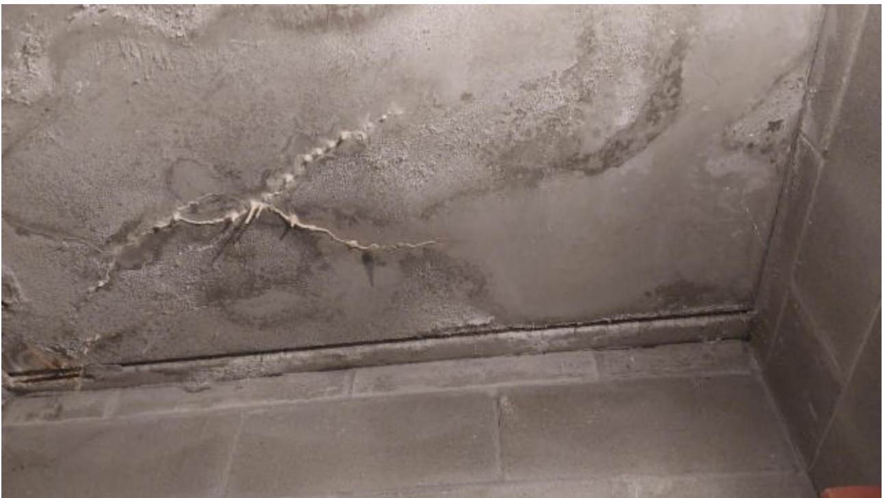
Particolare dell'intradosso del solaio della cantina.
