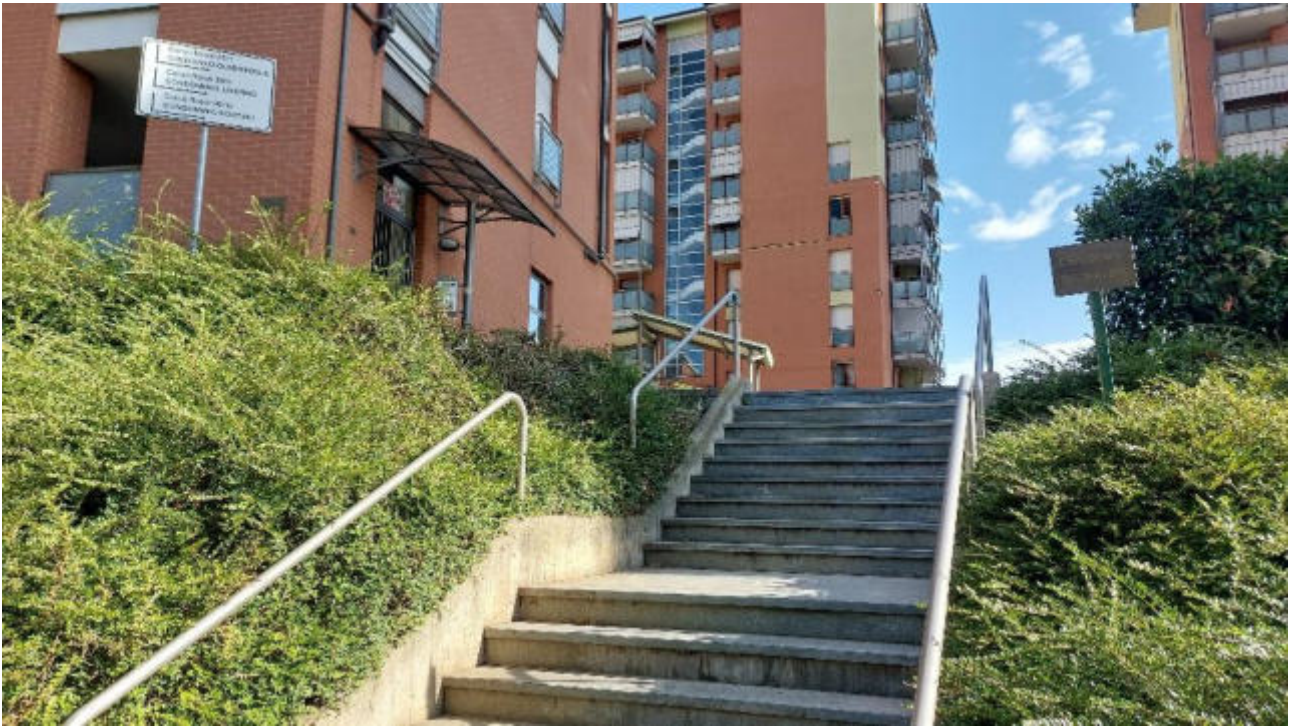
Vista del prospetto est dalla via pubblica.
