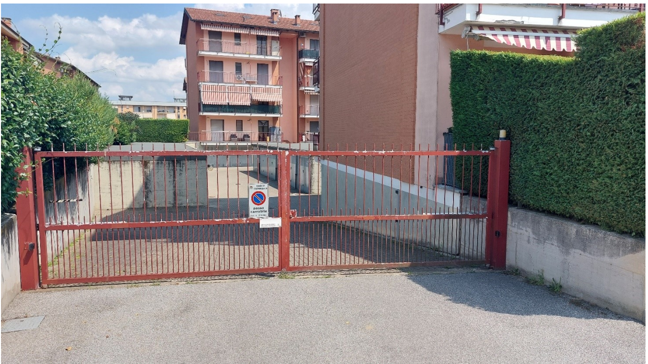
Vista dell'accesso carraio al civico 55 della via dei Sospiri.
