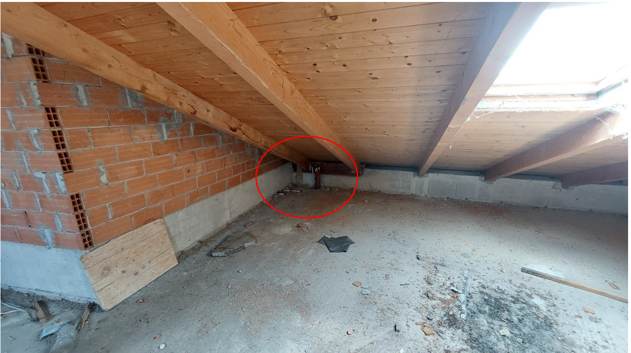
Particolare del secondo ambiente nel quale sono presenti delle predisposizioni per un impianto termoidraulico.
