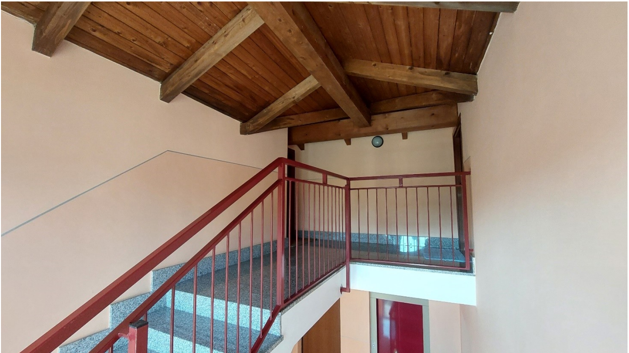
Vista del pianerottolo condominiale.
