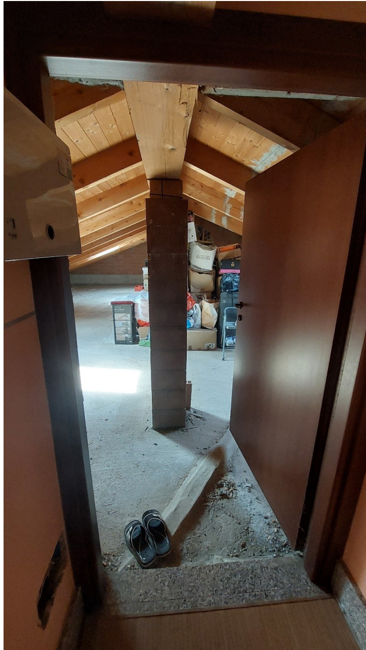
Vista dell'ingresso al sottotetto.
