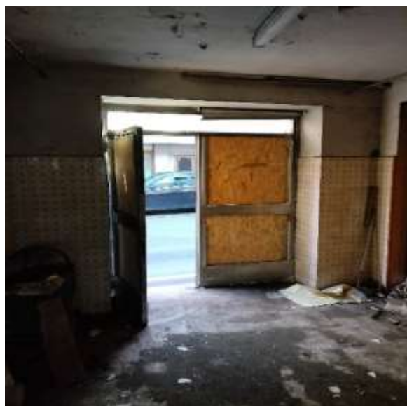
VISTA INTERNA PIANO TERRA
