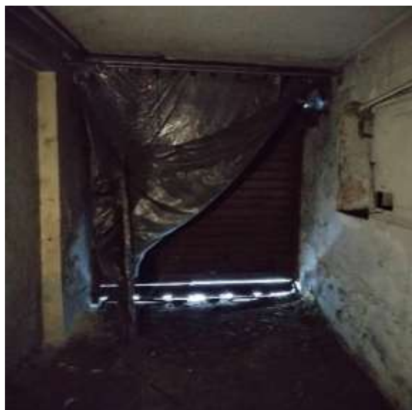
VISTA INTERNA AUTORIMESSA
