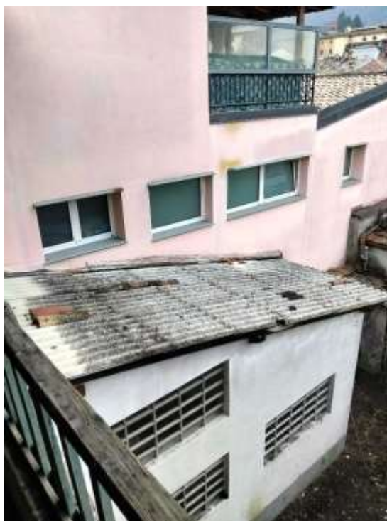
COPERTURA VANO SCALA E CORTILE INTERNO
