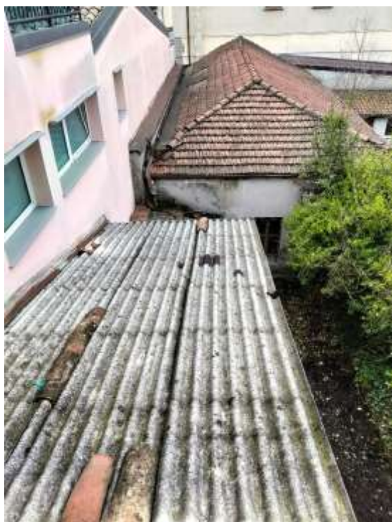
COPERTURA VANO SCALA E CORTILE INTERNO
