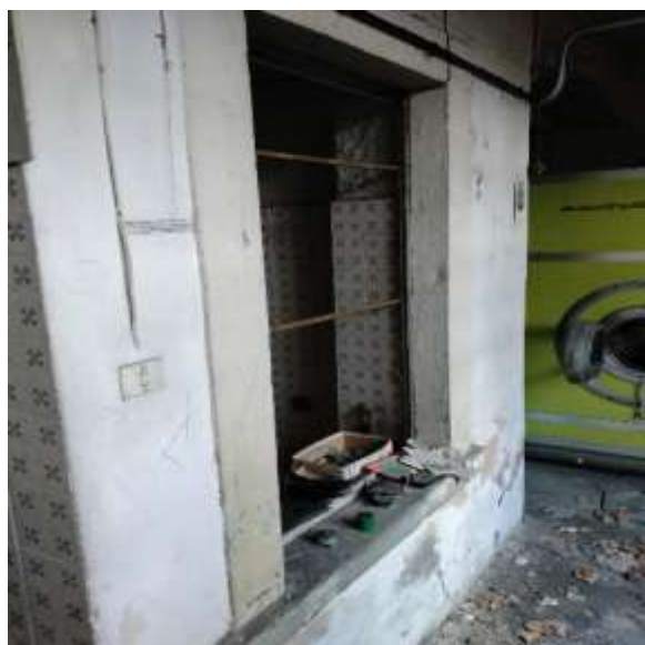
VISTA INTERNA PIANO TERRA
