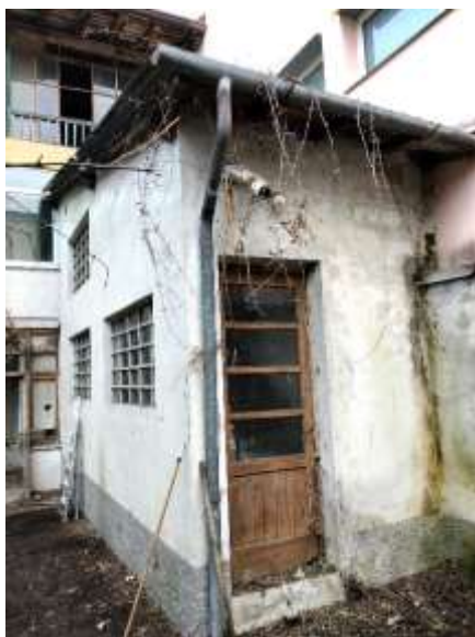
VISTA VANO SCALA
