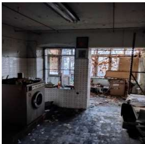
VISTA INTERNA PIANO TERRA
