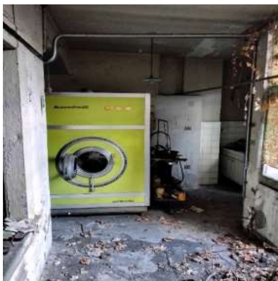
VISTA INTERNA PIANO TERRA
