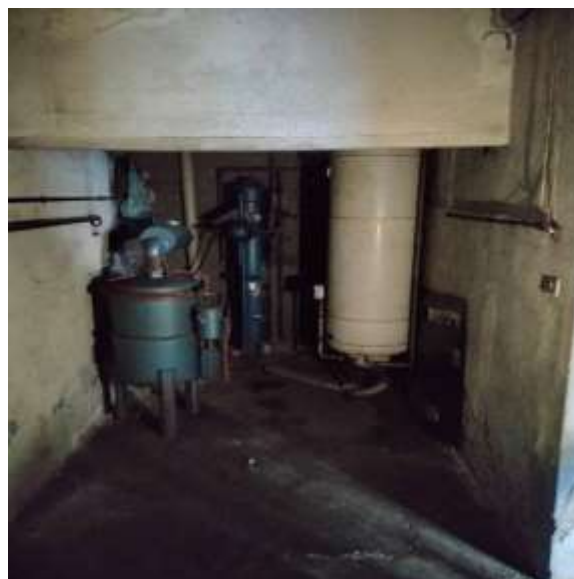
VISTA INTERNA AUTORIMESSA
