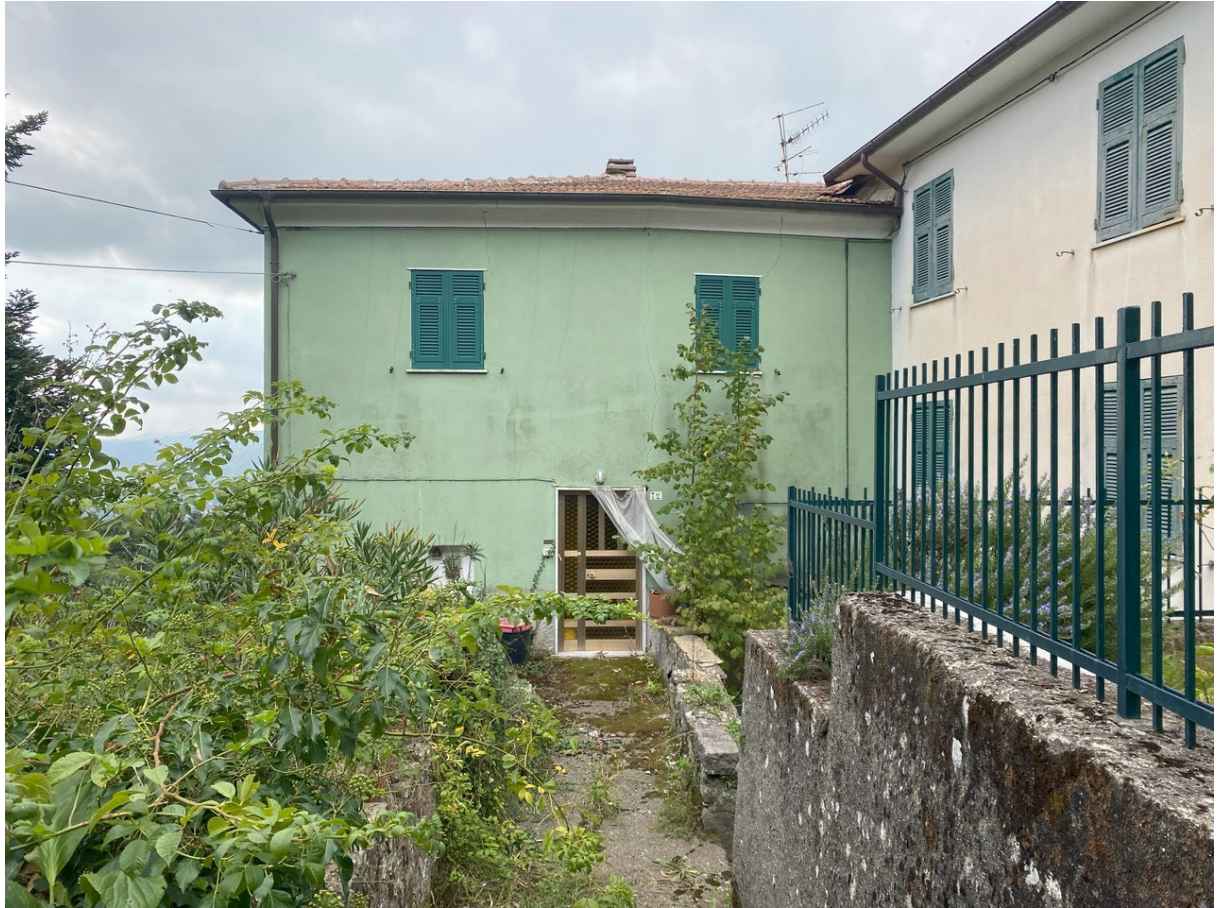
Foto 3 – l'accesso al fabbricato
