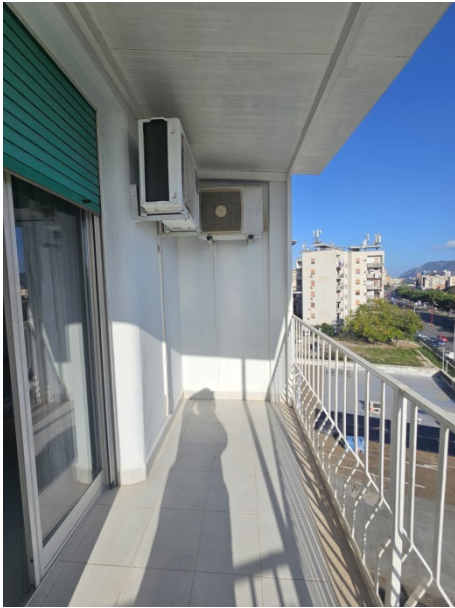
Foto.17 balcone adiacente alla camera
