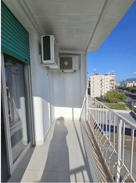
Foto.17 balcone adiacente alla camera
