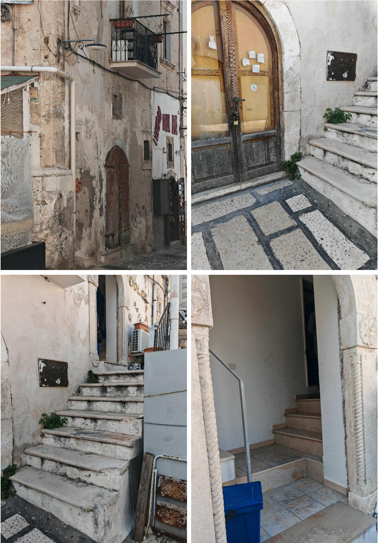
Figura 3: Fabbricato in Lucera (FG) località "Mezzanelle"- viste esterne
