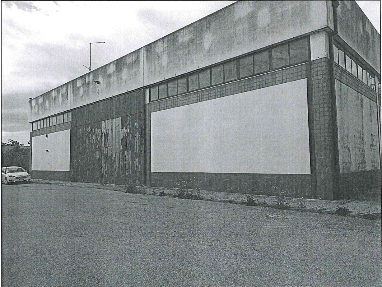
Figura C.4. Vista del capannone dagli spazi pertinenziali esterni.
