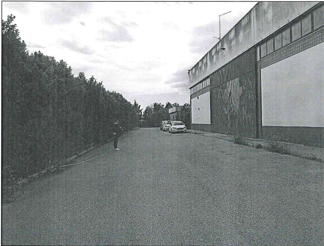
Foto C.1. Strada di accesso all'ingresso laterale del capannone.
