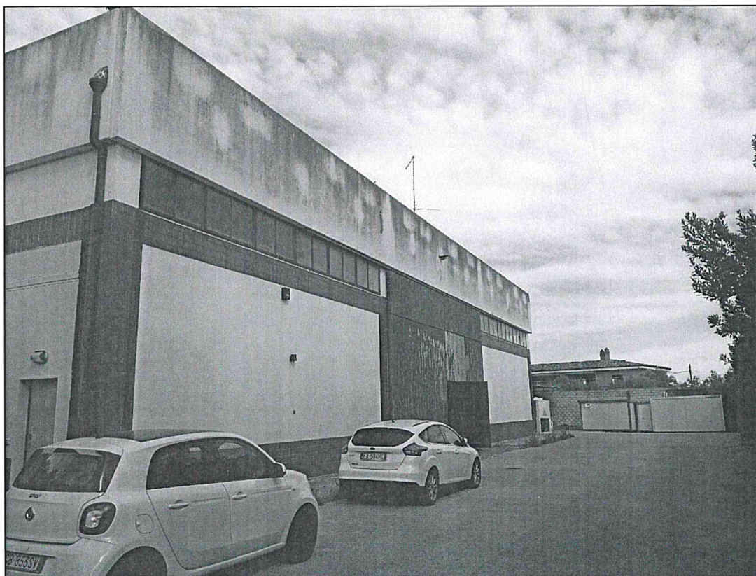
Foto C.3. Facciata laterale del capannone. Sulla sinistra, la porta di accesso agli uffici.
