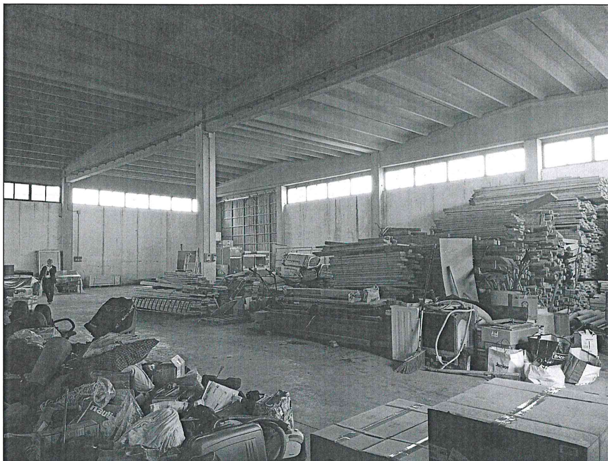
Figura C.5. Interno del capannone, porzione a tutta altezza.
