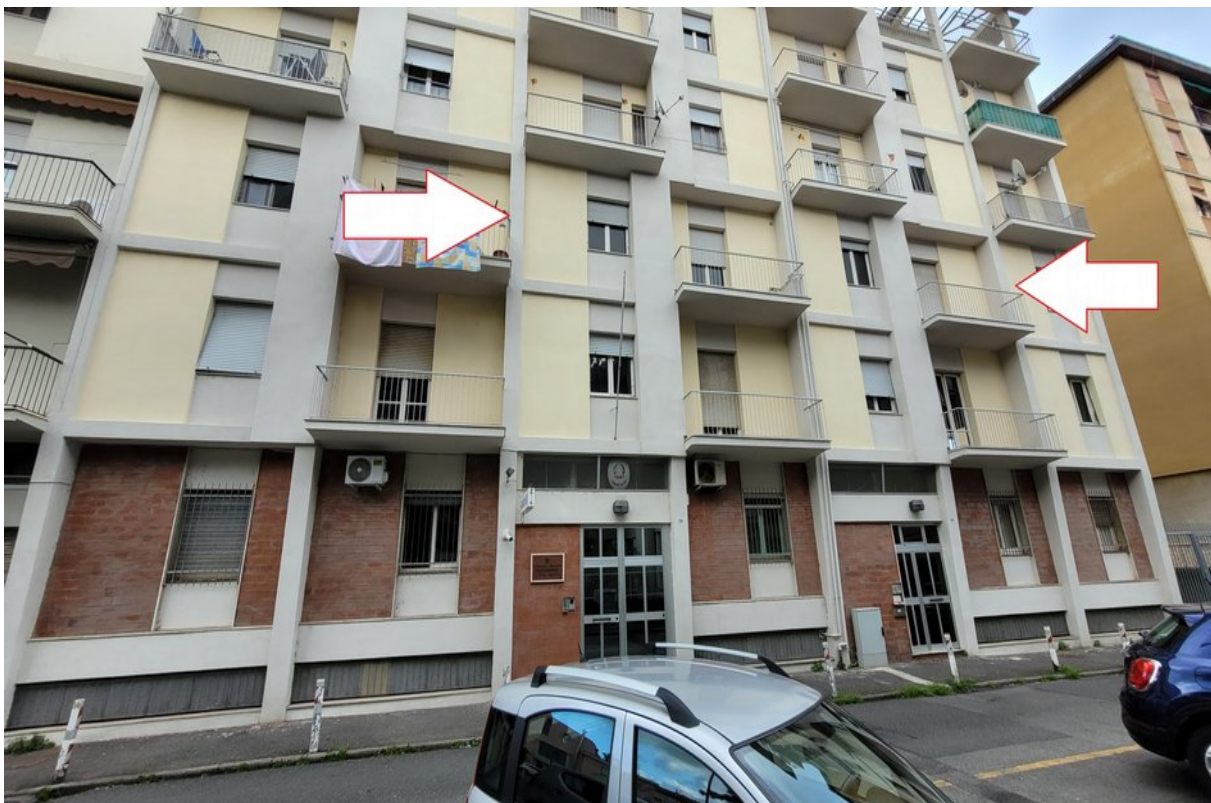
Panoramica lato Ovest-Via U.Foscolo
