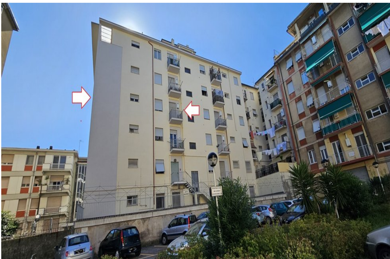
Panoramica vista lato Sud-Est
