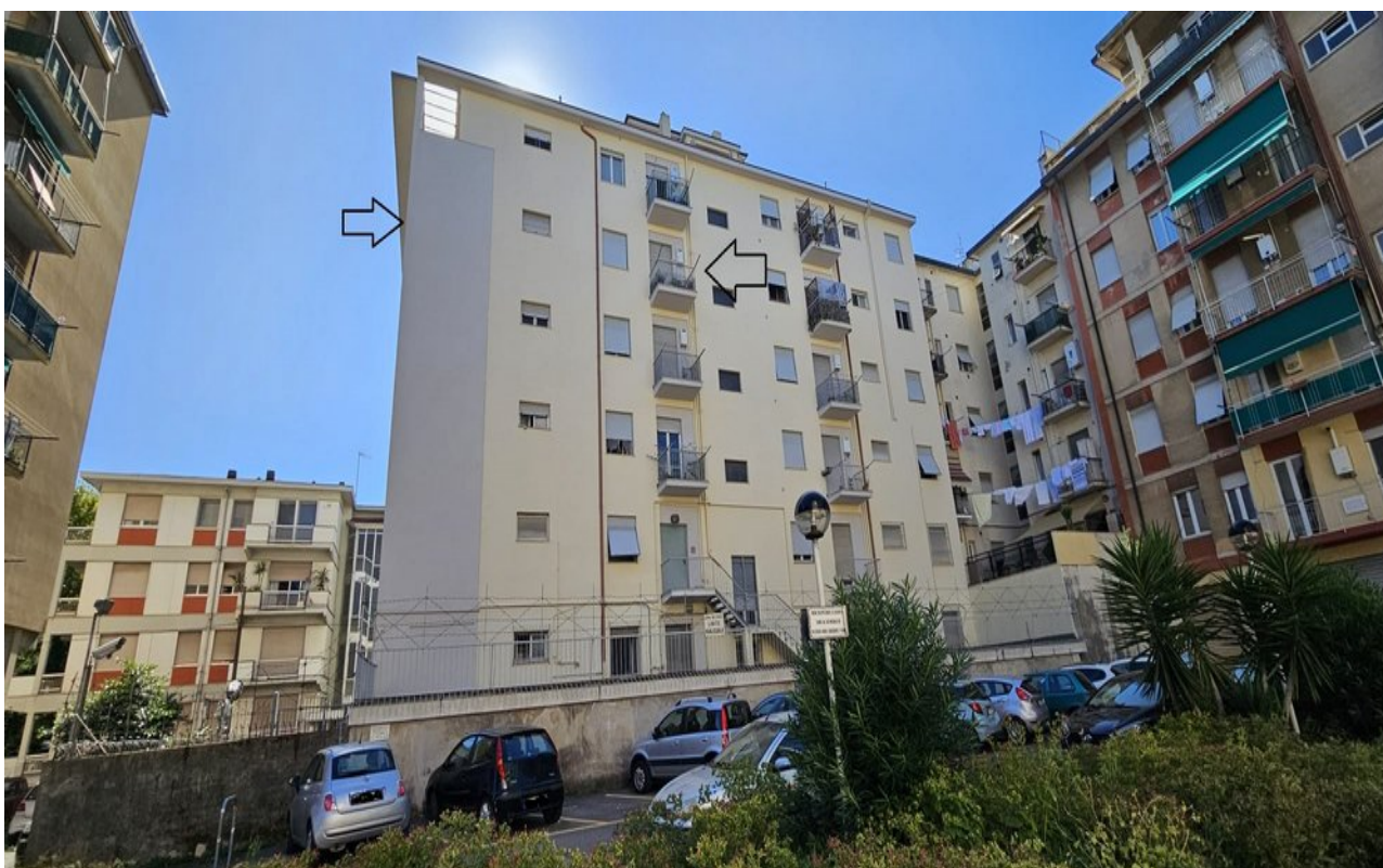
Panoramica vista lato Sud-Est
