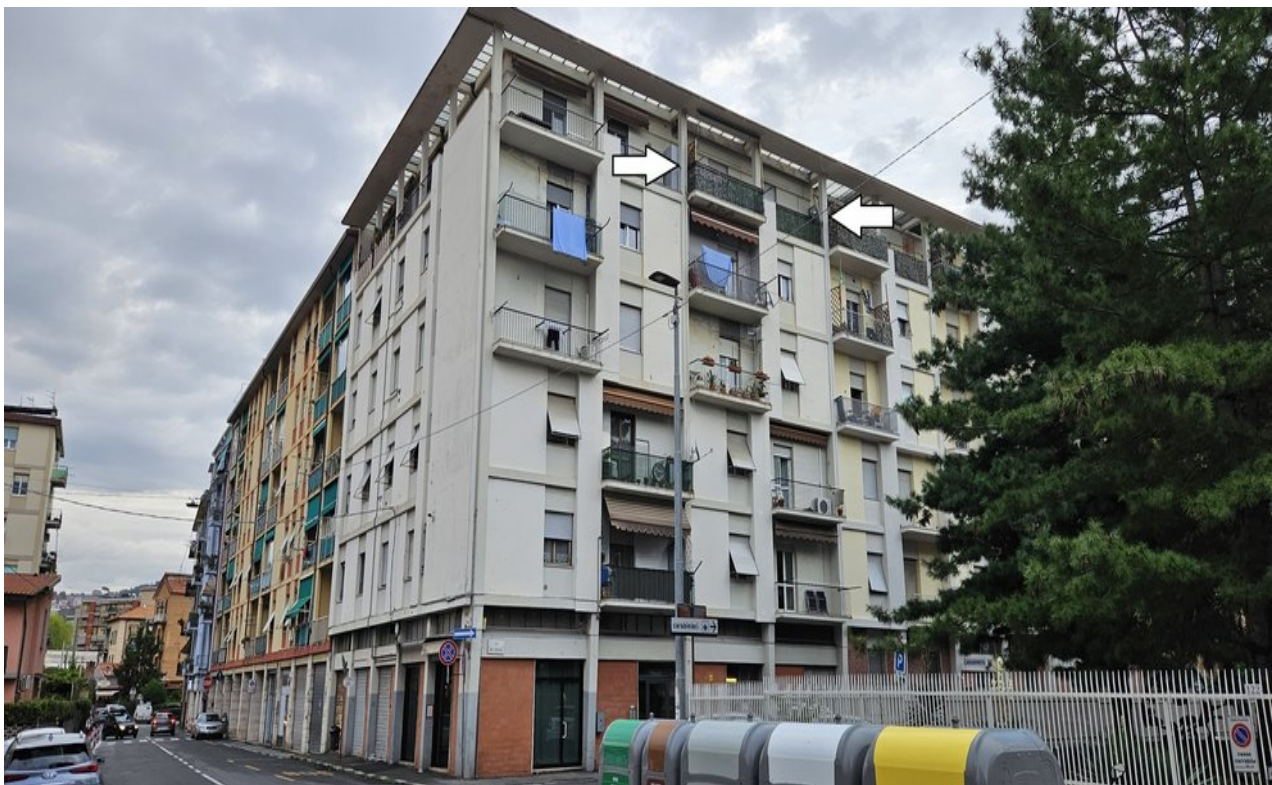
Panoramica lato Nord- Ovest – Via U. Foscolo
