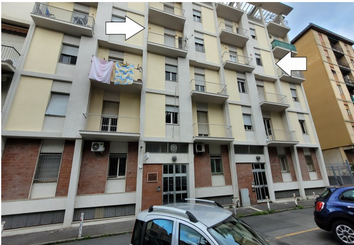
Panoramica lato Ovest – Via Ugo Foscolo
