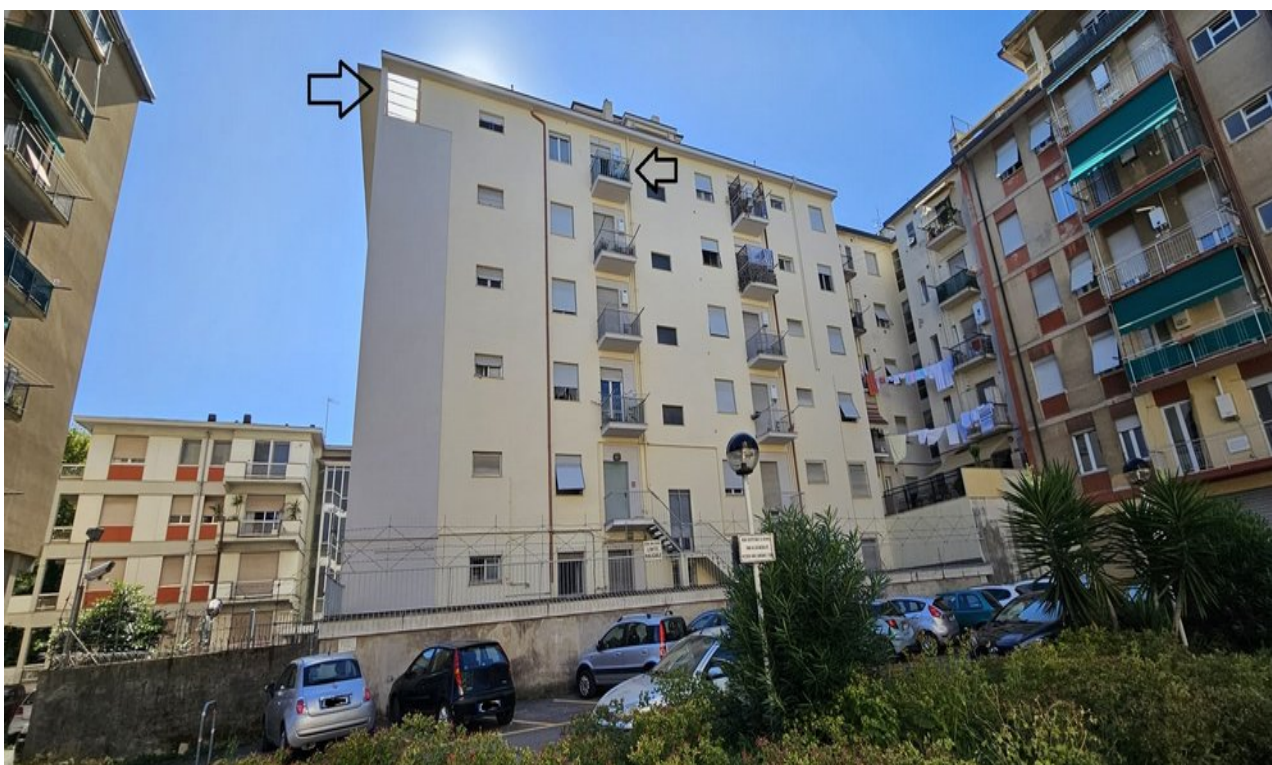
Panoramica vista lato Sud-Est
