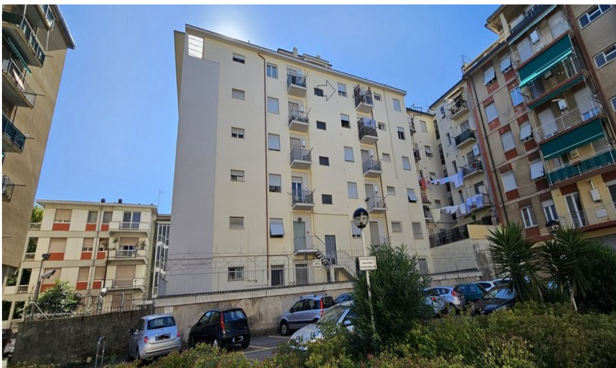
Panoramica vista lato Sud-Est
