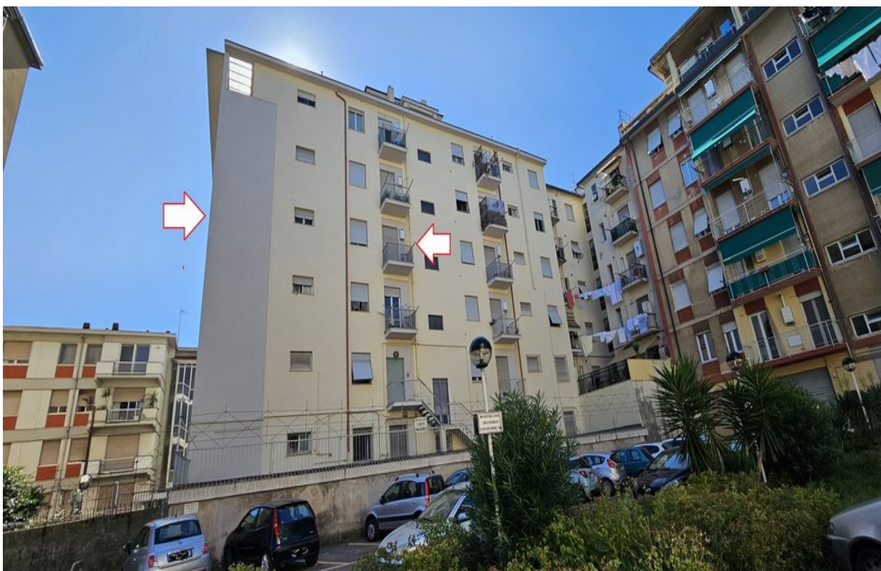
Panoramica vista lato Sud-Est
