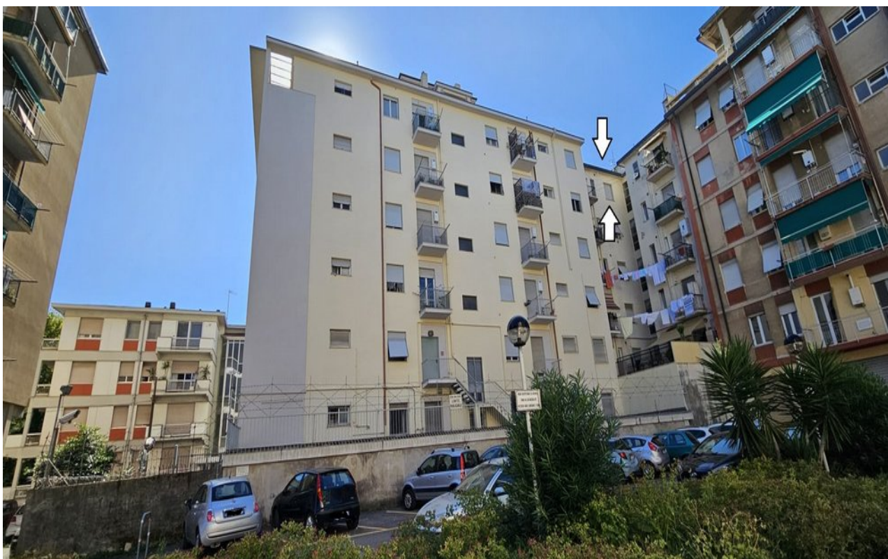
Panoramica vista lato Sud-Est
