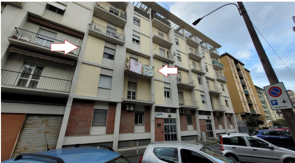
Panoramica lato Ovest-Via U.Foscolo
