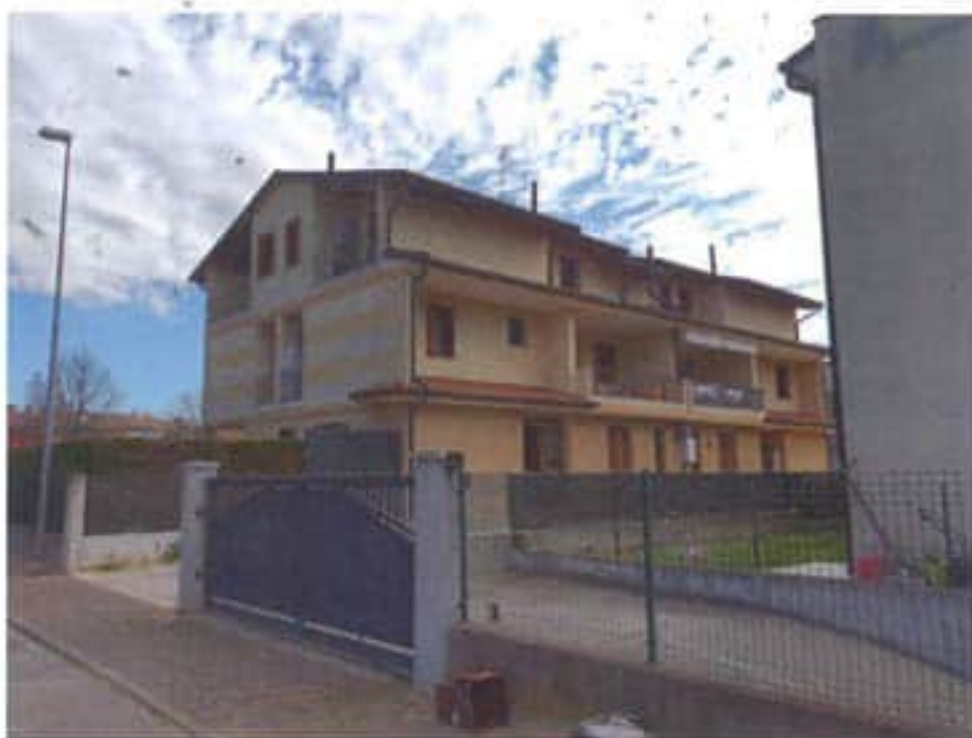
Fotografia E.5 - Vista esterna
