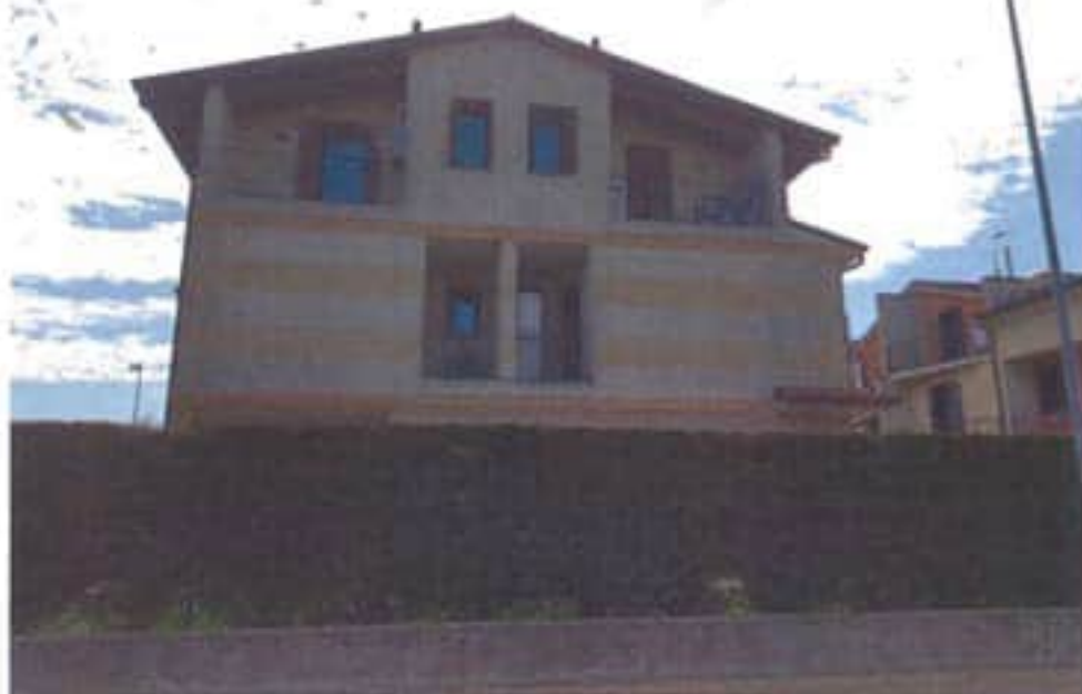
Fotografia E.3 - Vista esterna
