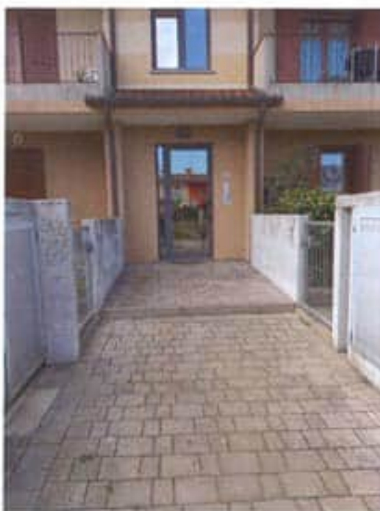
Fotografia E.2 - Vista esterna
