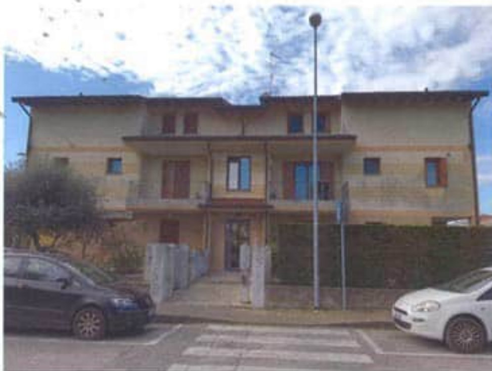
Fotografia E.1 - Vista esterna
