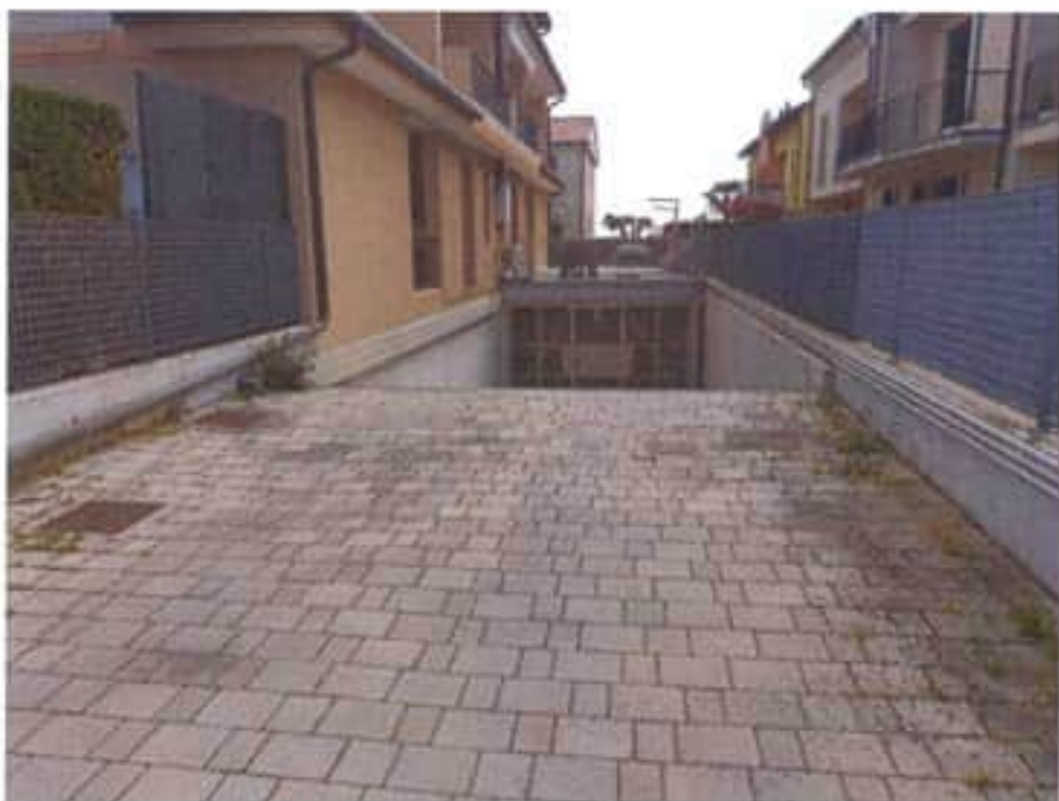
Fotografia E.4 - Vista esterna
