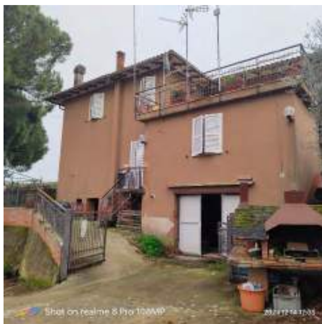
Edificio residenziale - Vista da strada interna
