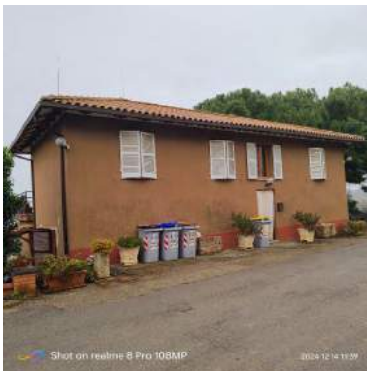
Edificio residenziale - Vista da strada provinciale 301 "Pozzuolo"
