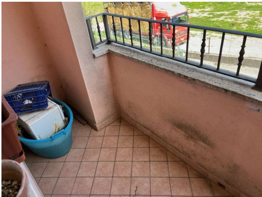
FOTO n°30 – LOTTO A, UNITÀ ABITATIVA 1°P, terrazzo piccolo
