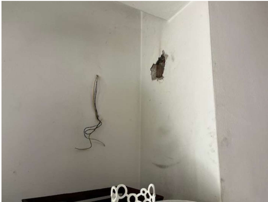
FOTO n°13 – LOTTO A, UNITÀ ABITATIVA 1°P, cucina, impianto elettrico
