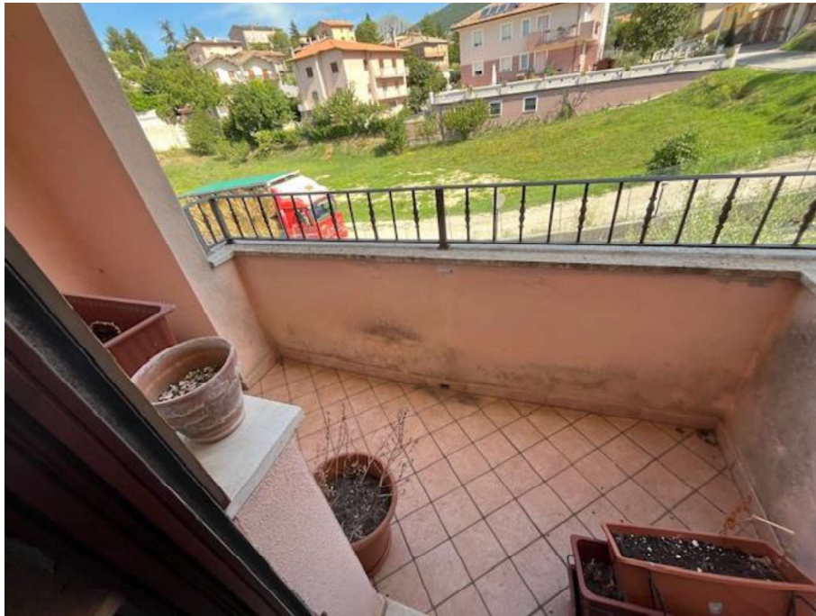
FOTO n°29 – LOTTO A, UNITÀ ABITATIVA 1°P, terrazzo piccolo
