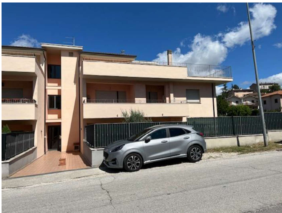
FOTO n°4 – via XXV APRILE, s.n.c. a GUALDO TADINO (PG) - Abitazione al 1°P
