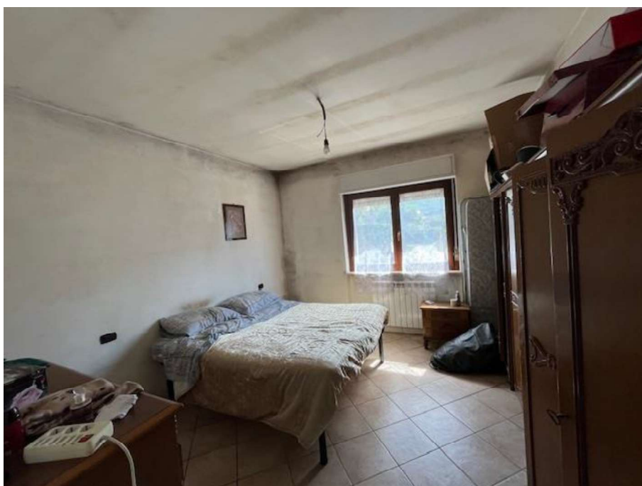
FOTO n°20 – LOTTO A, UNITÀ ABITATIVA 1°P, camera
