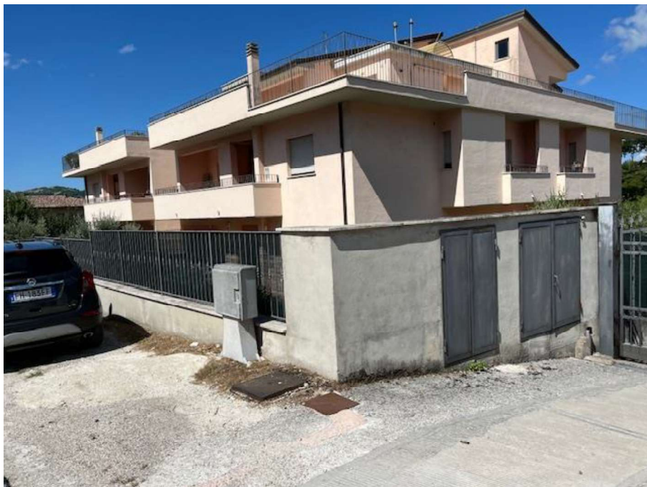
FOTO n°2 – via XXV APRILE, s.n.c. a GUALDO TADINO (PG) - Abitazione al 1°P
