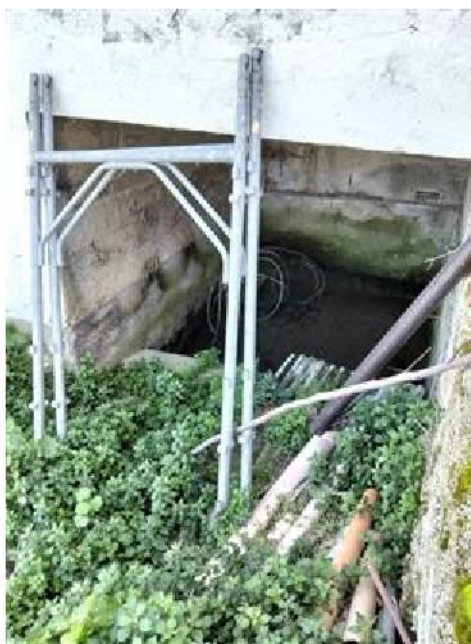
Parte sottostante il ripostiglio da rimuovere
