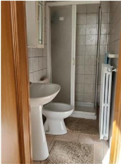
Bagno del Primo Piano
