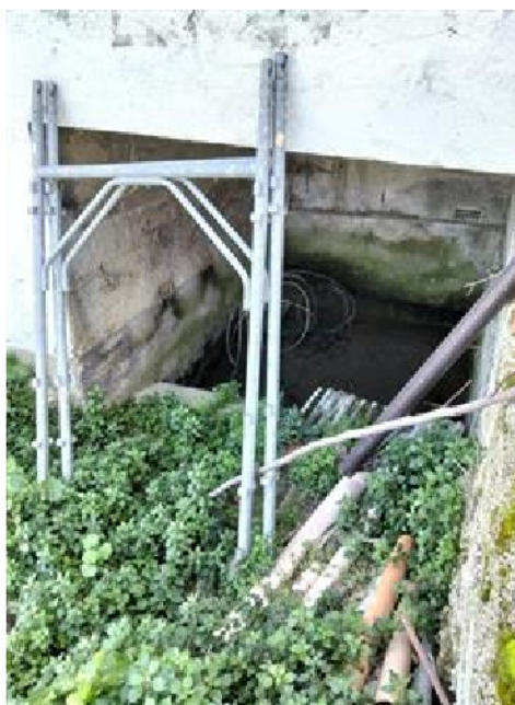
Parte sottostante il ripostiglio da rimuovere
