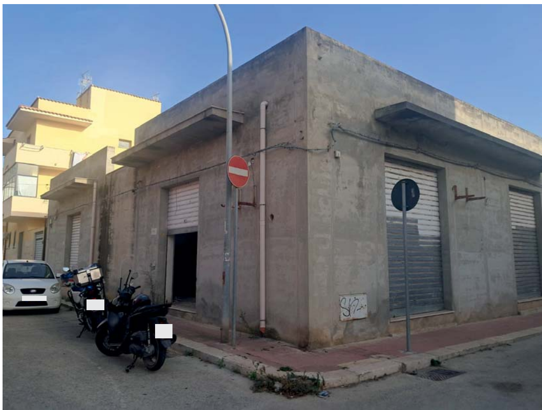
Foto 1 Prospetto su via Bartolomeo Augugliaro angolo via del Cipresso
