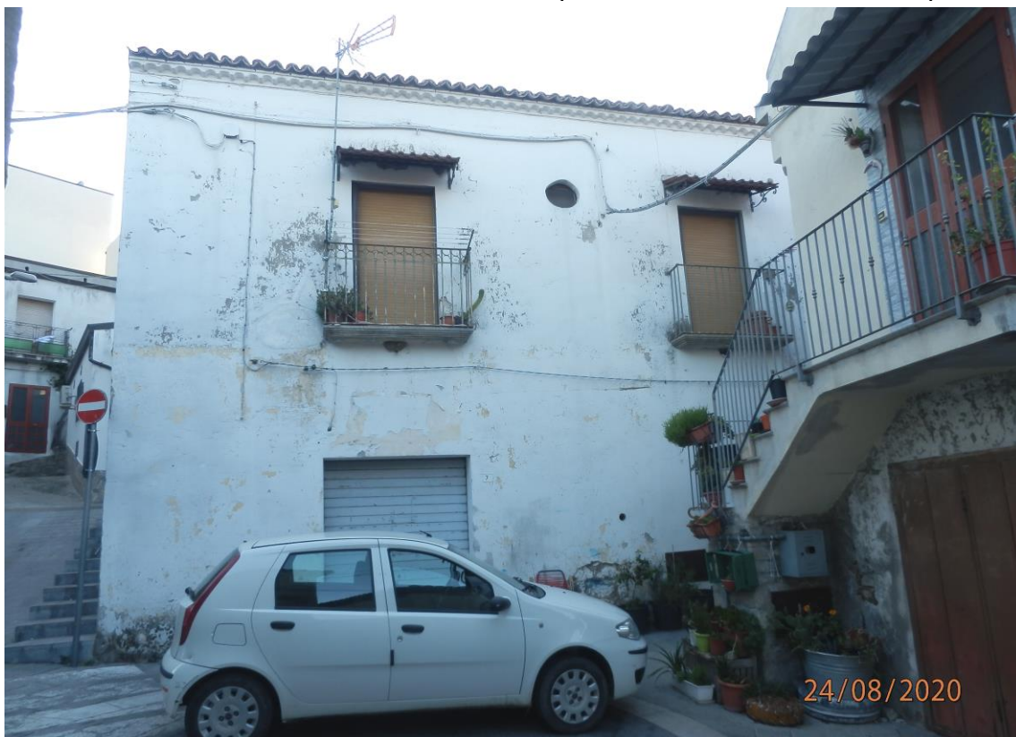
Foto 1 - vista dell'edificio da via dei Caduti
