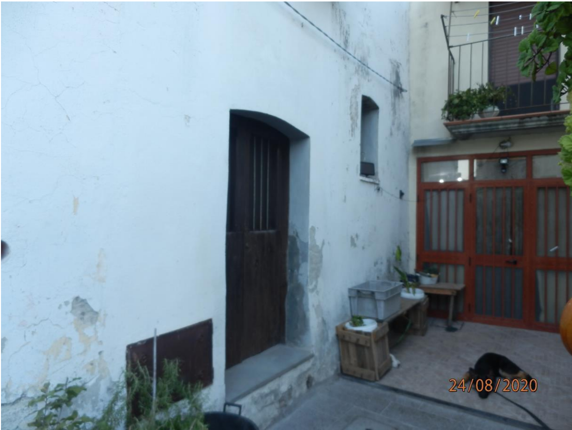
Foto 11 - via dei Caduti n.5 (Corpo B)
