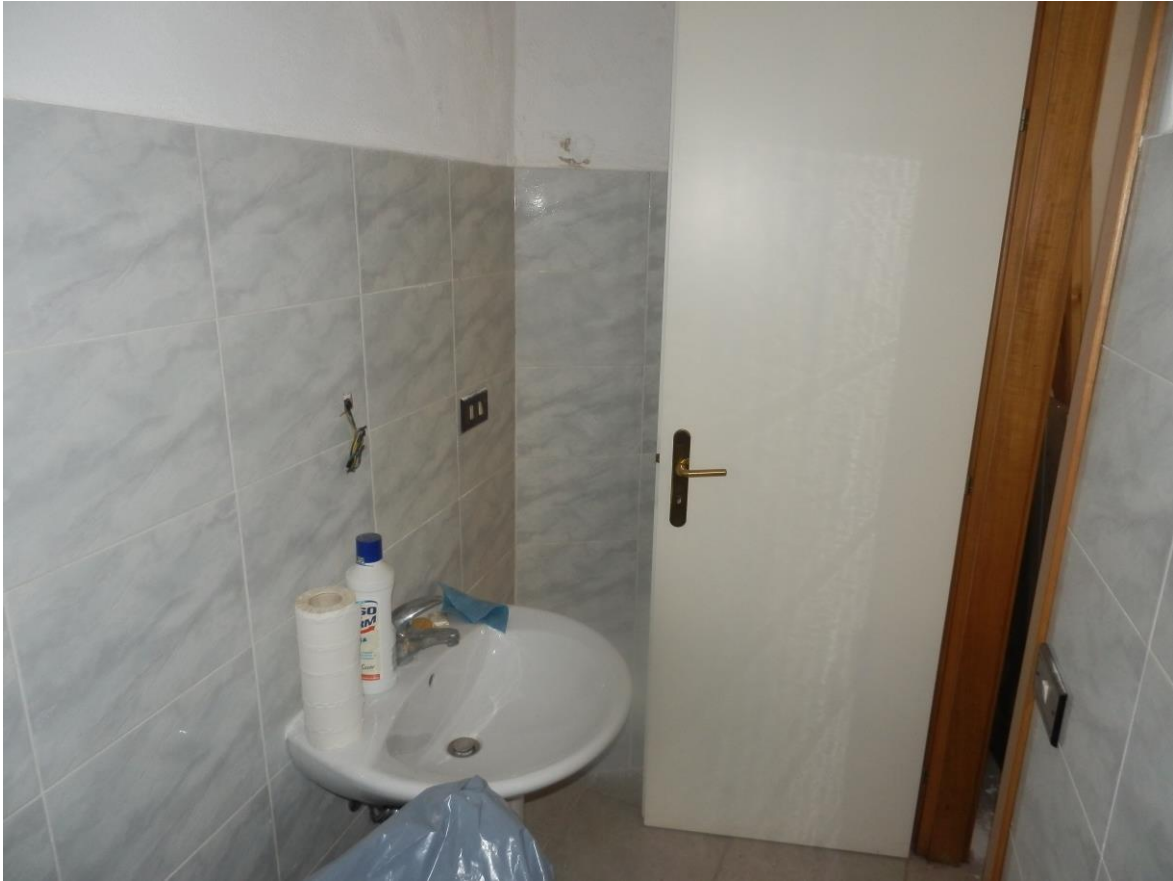
Foto 13 - Wc (Corpo B)
