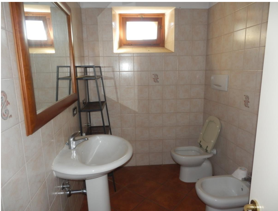
Foto 9 - bagno (Corpo A)
