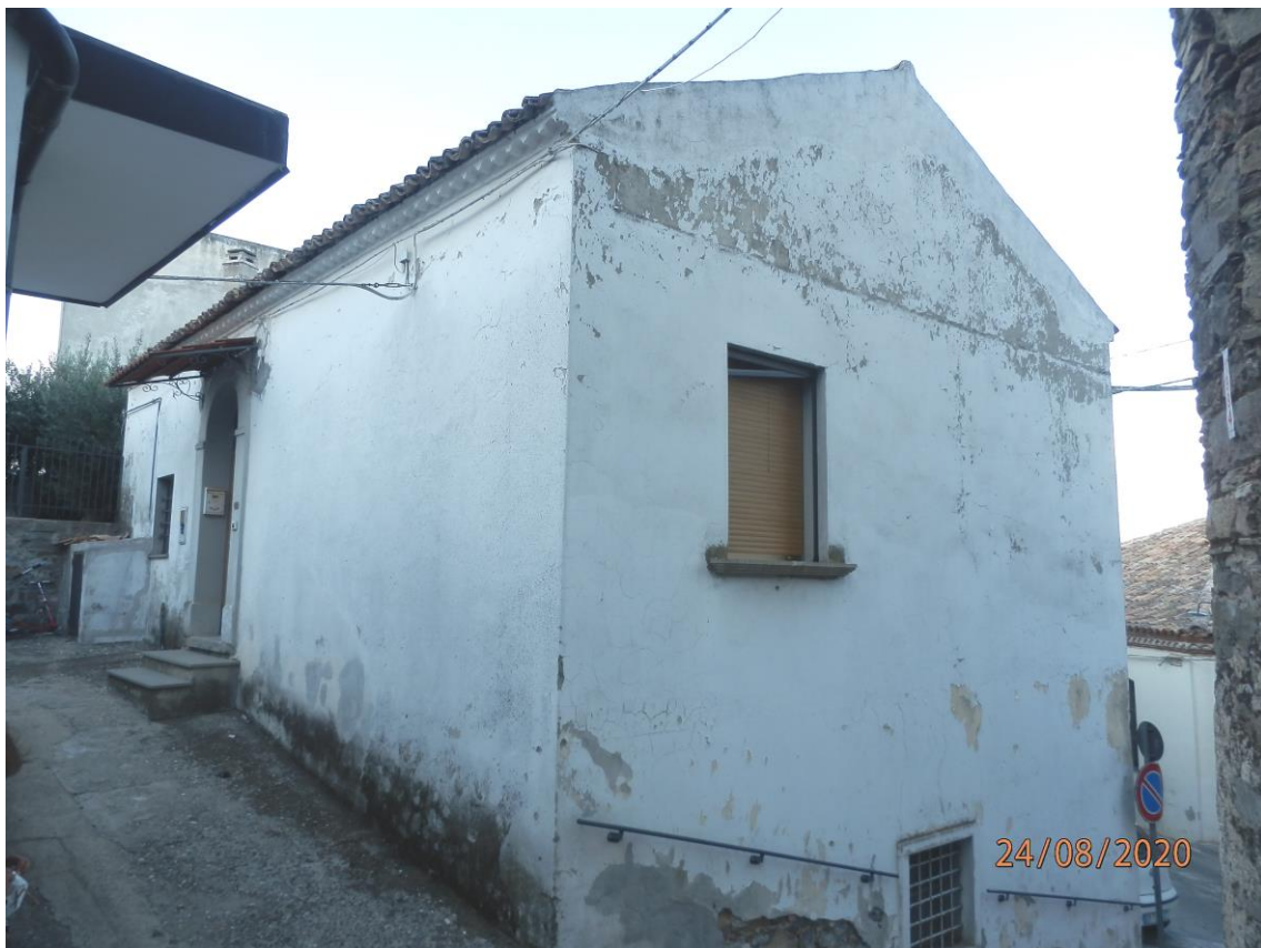
Foto 2 - vista dell'edificio dalla discesa di via Cirillo
