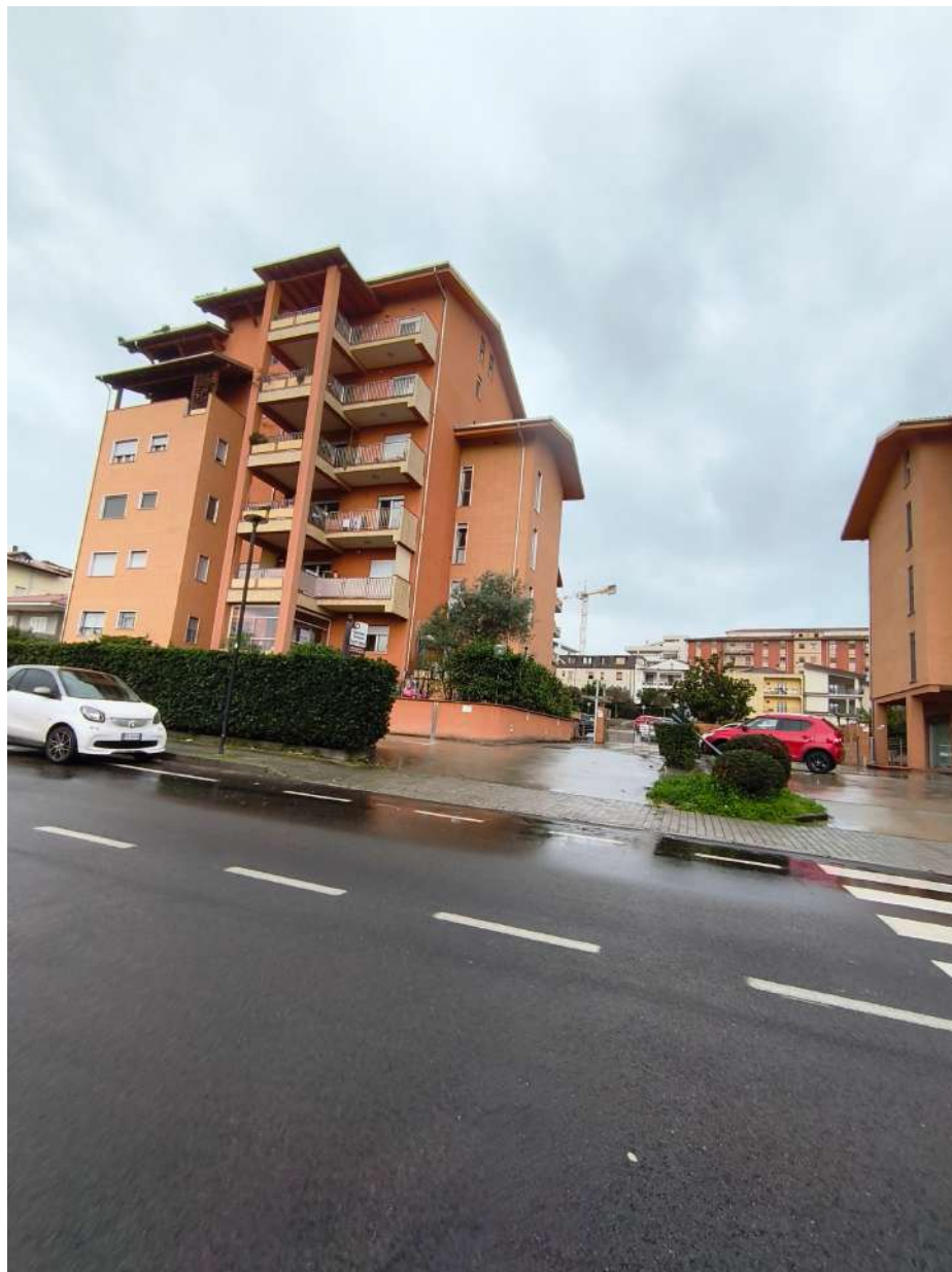
Foto n. 4: Fabbricato di cui fa parte l'immobile pignorato
