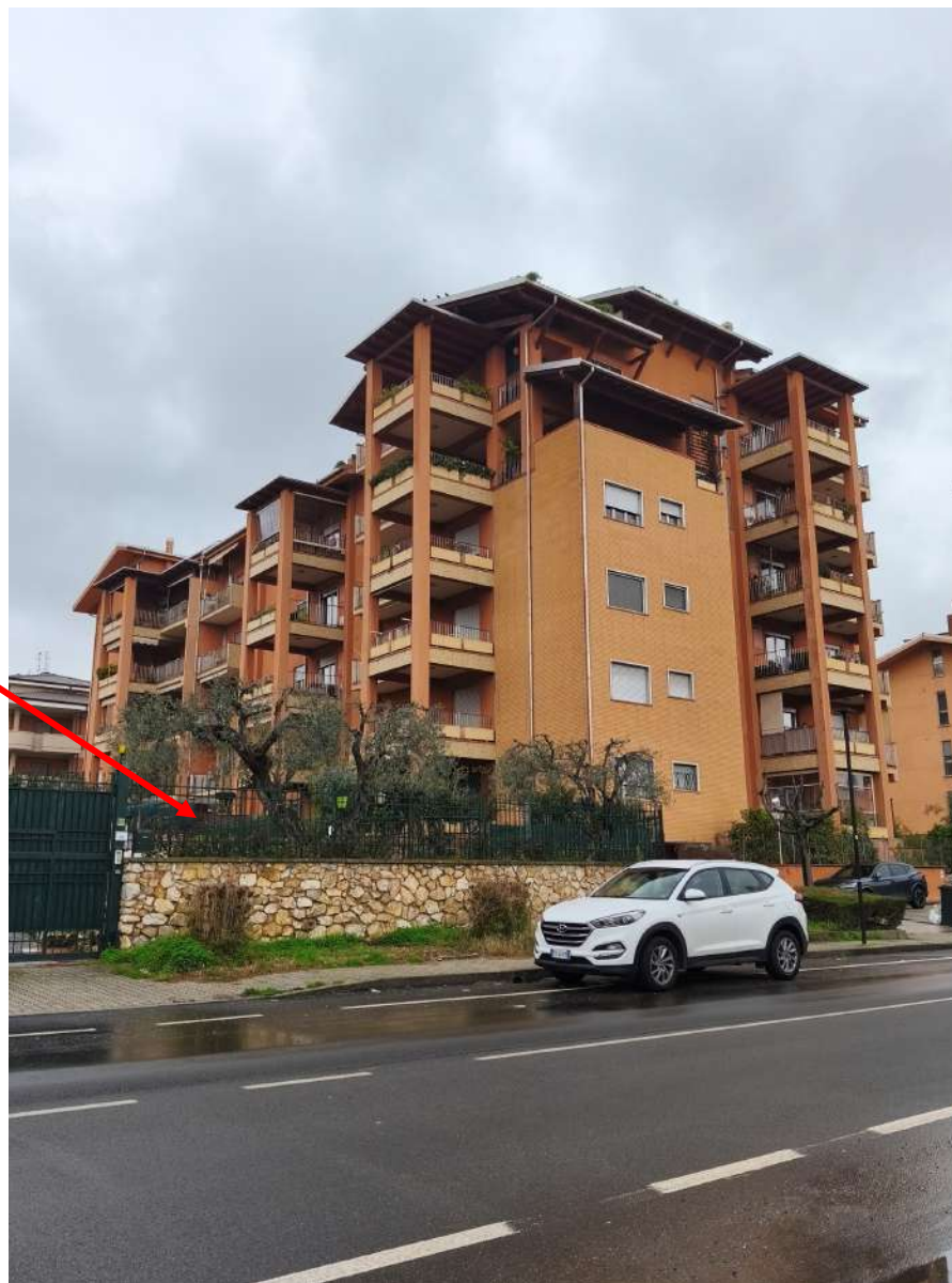
Foto n. 3: Fabbricato di cui fa parte l'immobile pignorato
