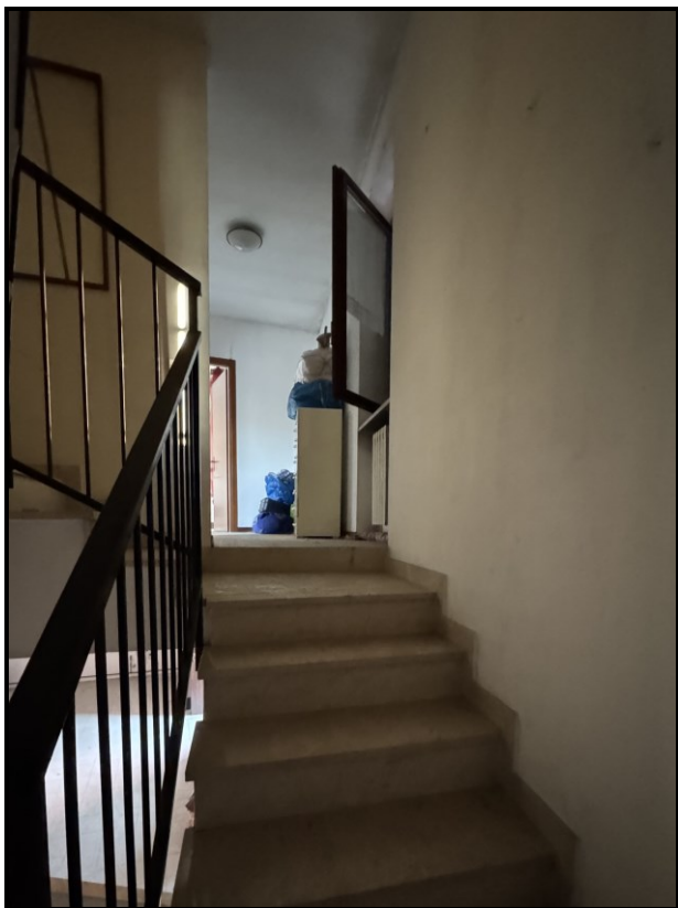
Foto 9: Il vano scala.
