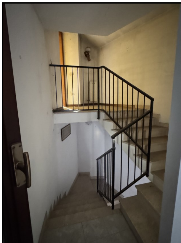
Foto 16: Il vano scala.
