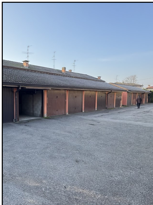
Foto 4: Prospetto del fabbricato in cui è inserito il box pignorato.
