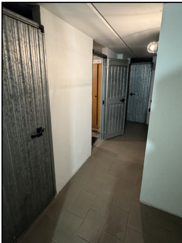
Foto 23: Il corridoio di accesso alle cantine.
