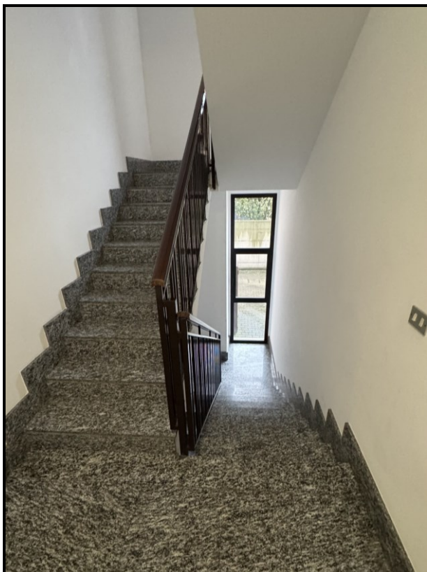
Foto 3: Il vano scala condominiale.
