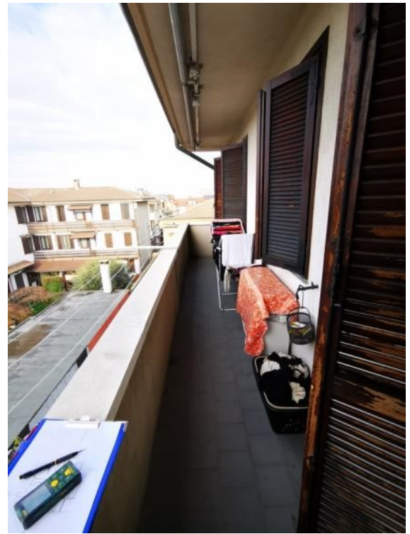
Alloggio piano terzo -balcone di ovest-
