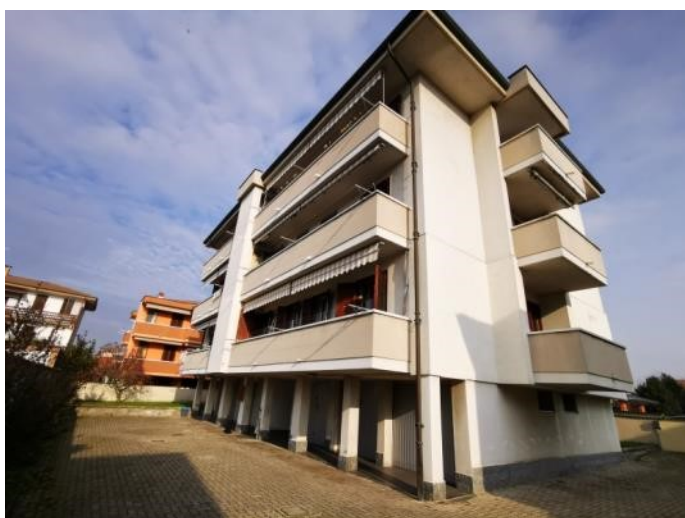
Fronte sud ed ovest
