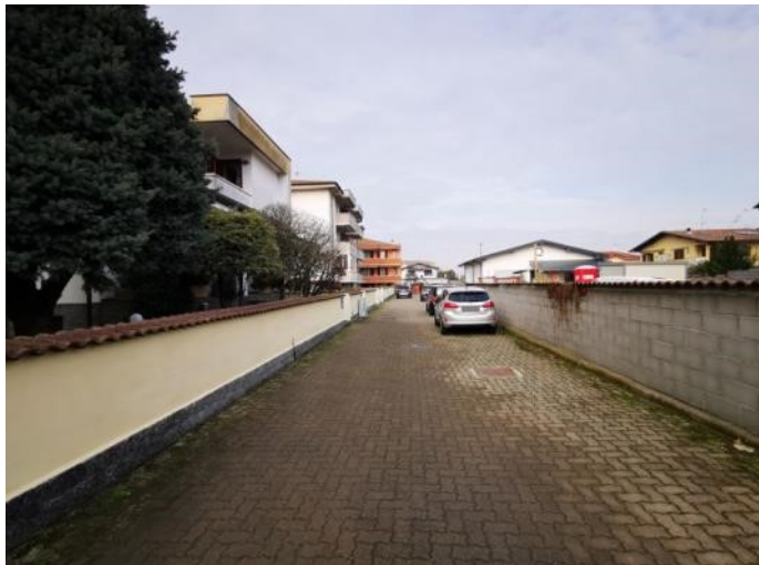
Tratto privato della Via Strettura
