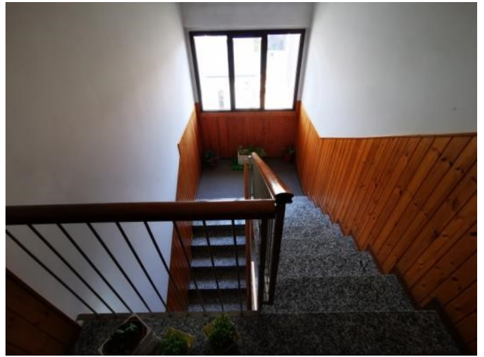
Vano scala condominiale
