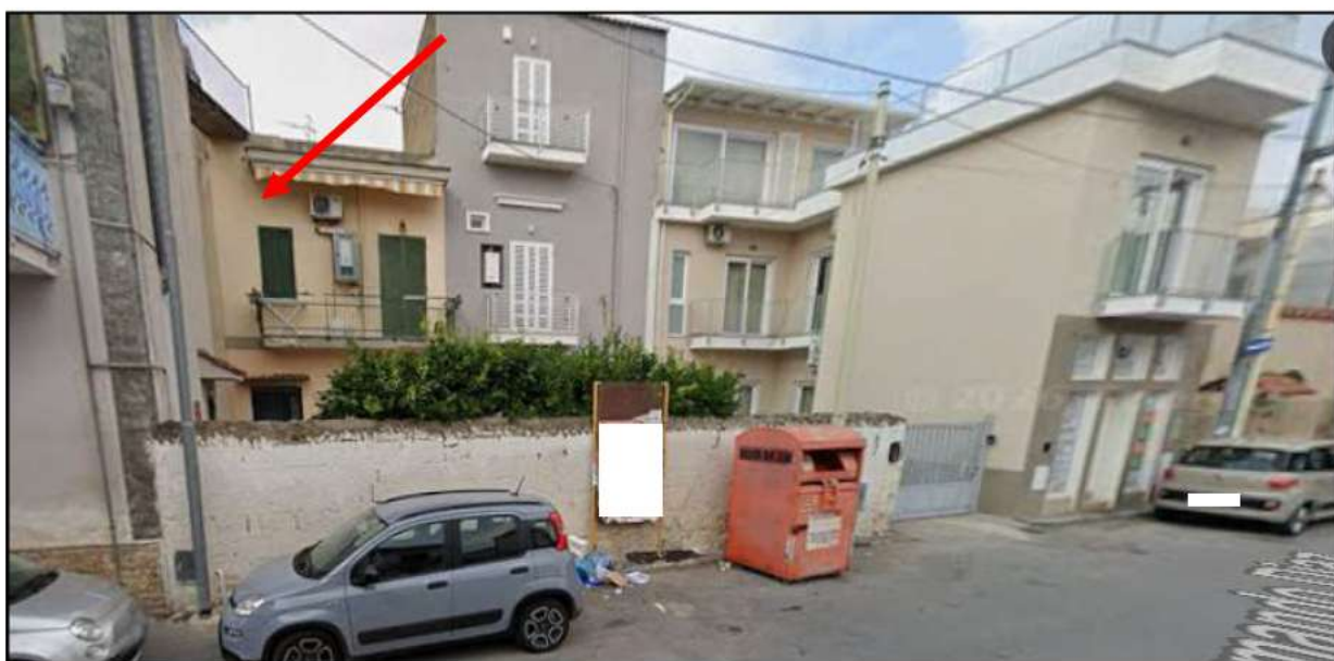
Prospetto dell'edificio su via A. Diaz
