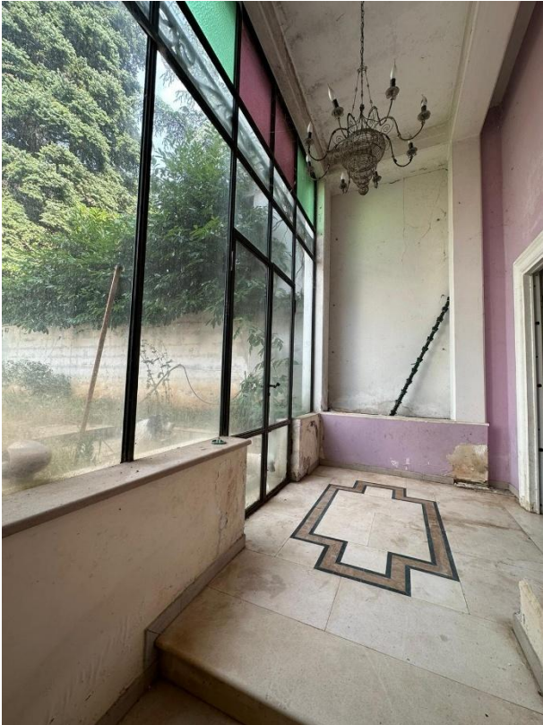
Foto6: Accesso cortesia esclusiva
