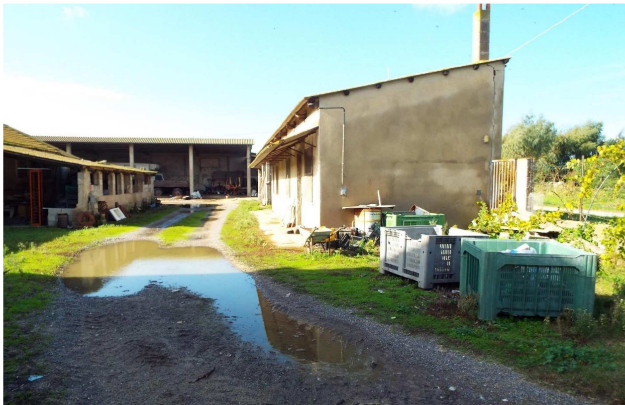
Figura n. 3: viabilità interna al complesso
