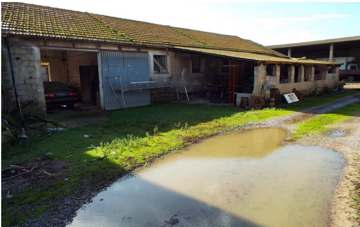
Figura n. 16: prospetto nord ex-stalla e tettoia
