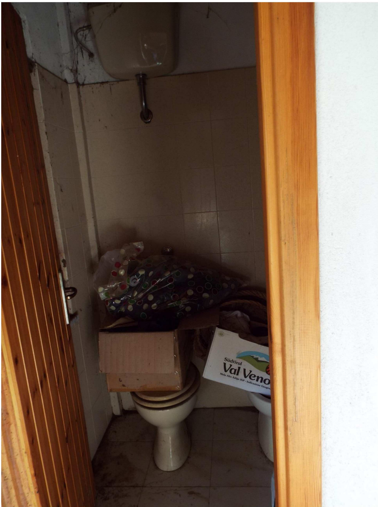
Figura n. 24: abitazione ex magazzino - bagno
