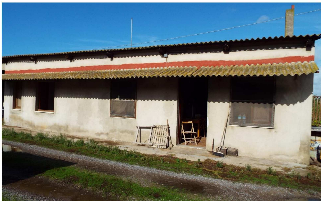
Figura n. 21: abitazione ex magazzino
