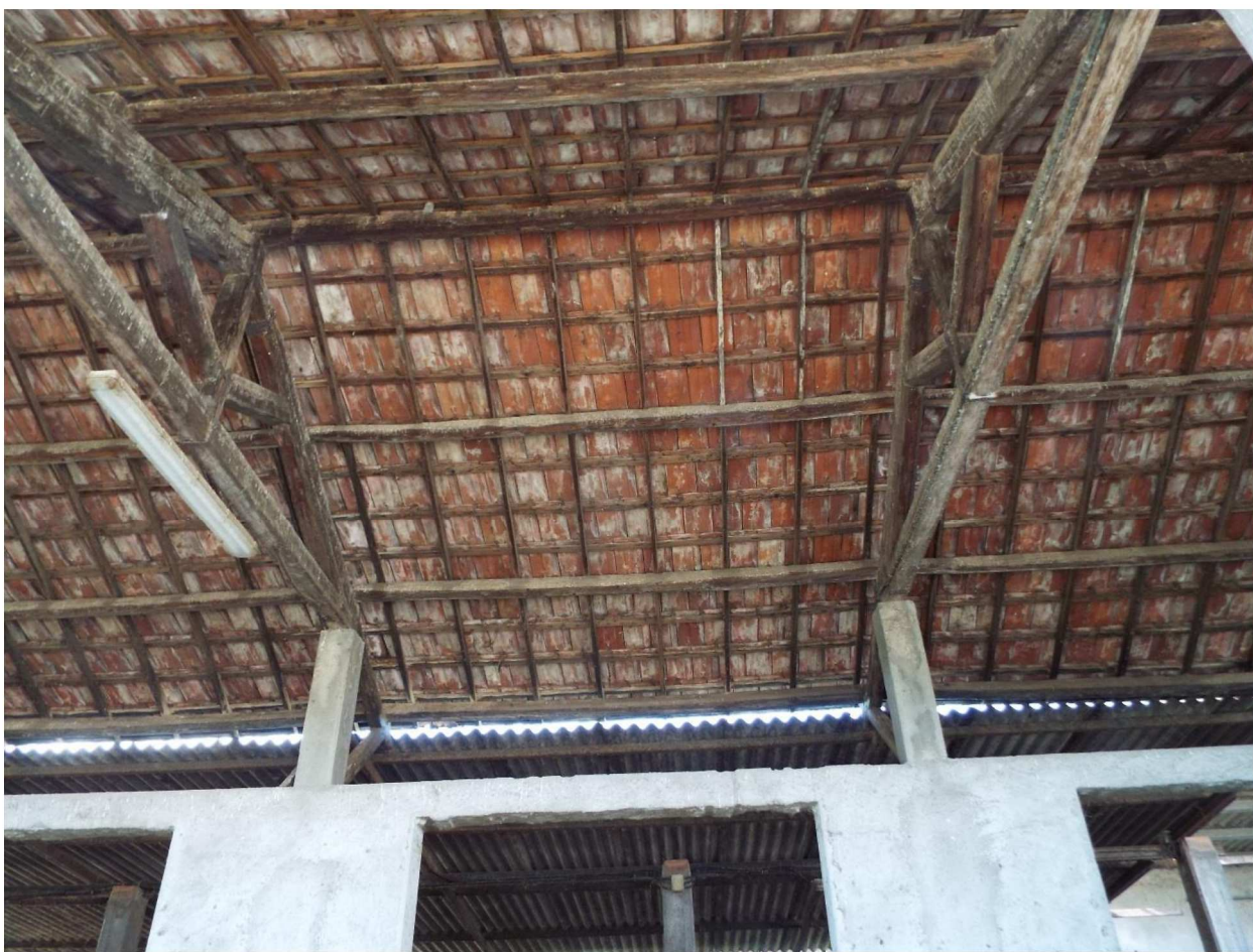
Figura n. 32: interno stalla ex fienile
