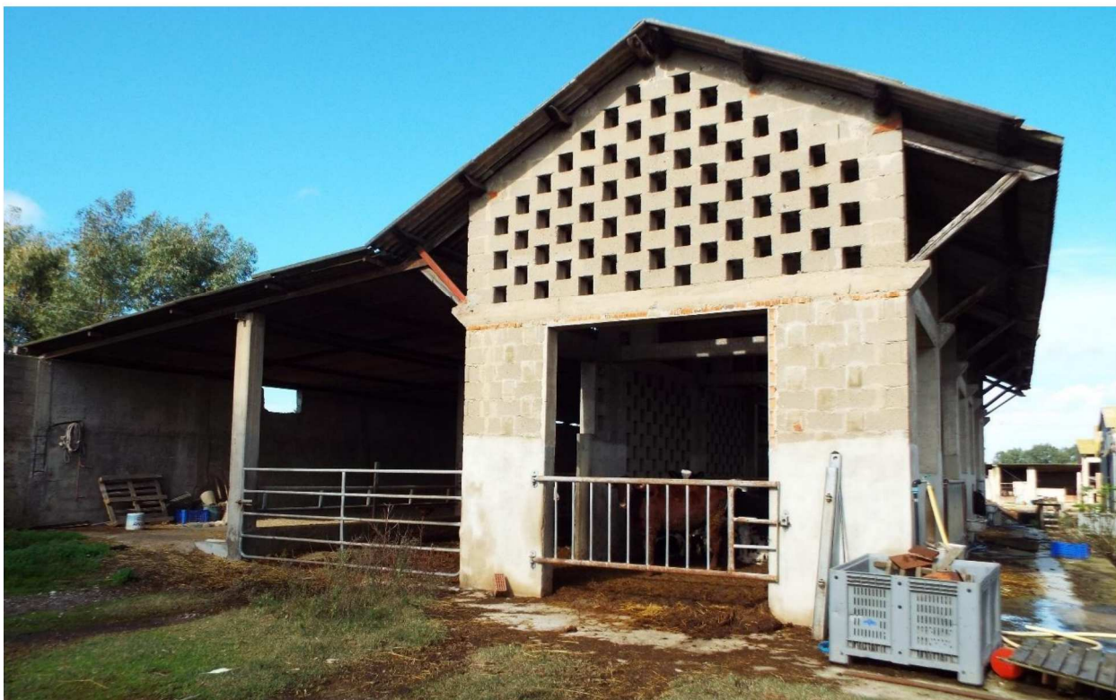
Figura n. 31: stalla ex fienile / ricovero mezzi - prospetto sud
