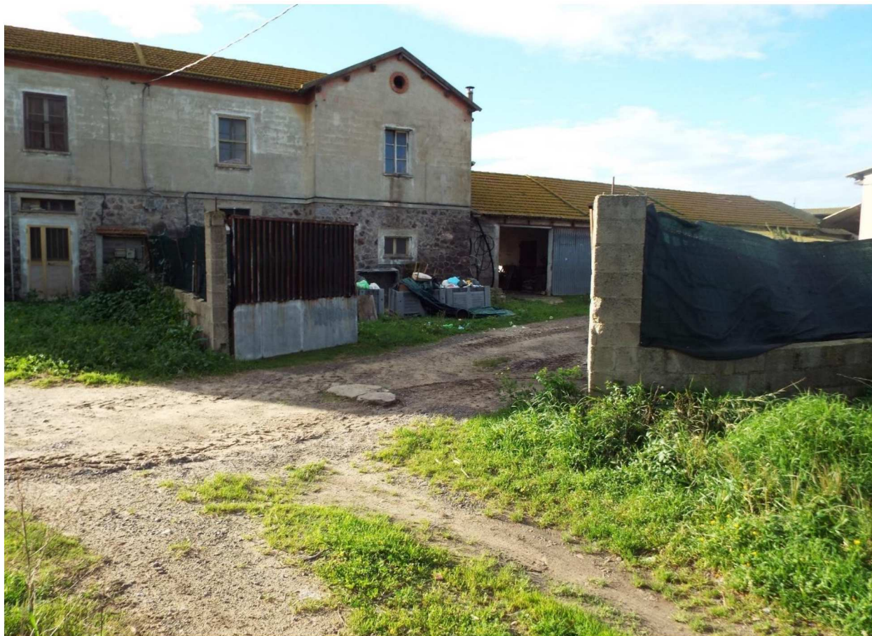
Figura n. 1: ingresso e prospetto nord della casa colonica
