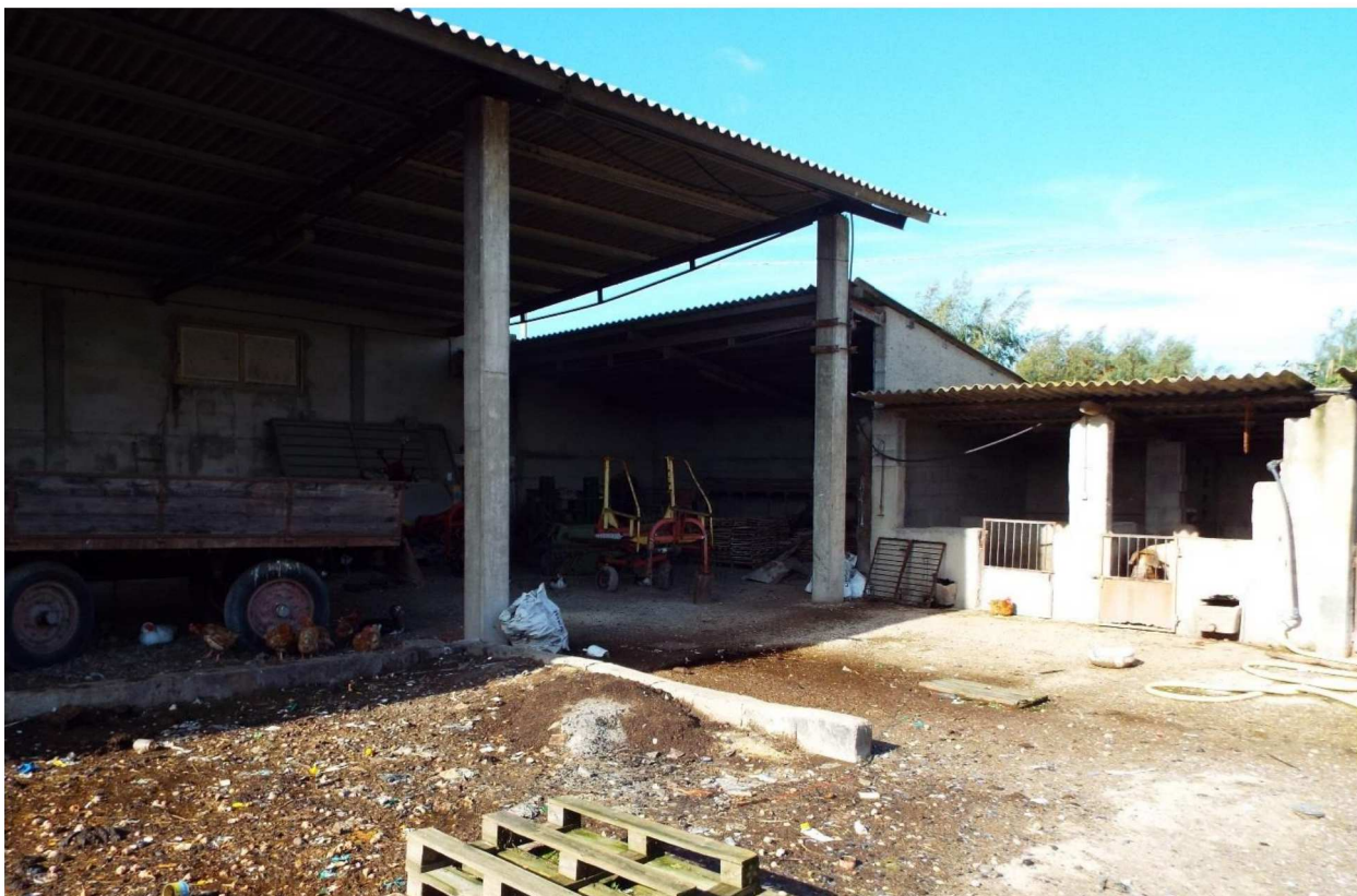
Figura n. 27: porcilaia / deposito attrezzi / ricovero mezzi
