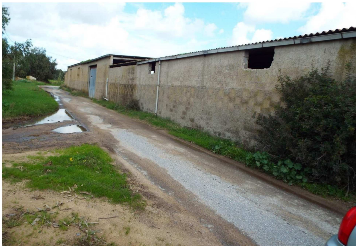
Figura n. 4: muro di confine lato ovest
