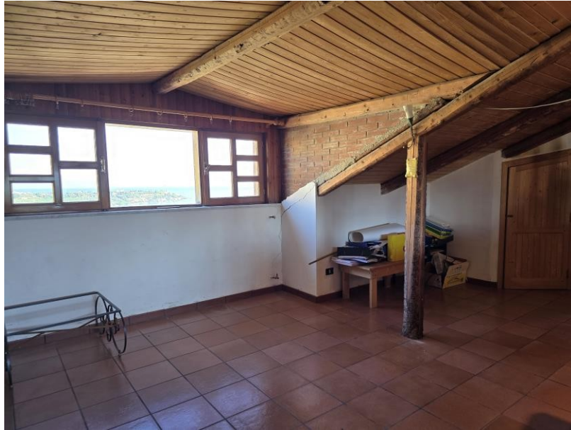
Foto n. 12 PIANO SECONDO – mansarda
