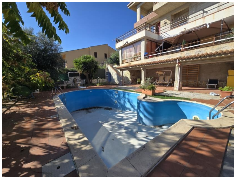
Foto n. 16 PIANO S2, secondo sottostrada – portico e piscina
