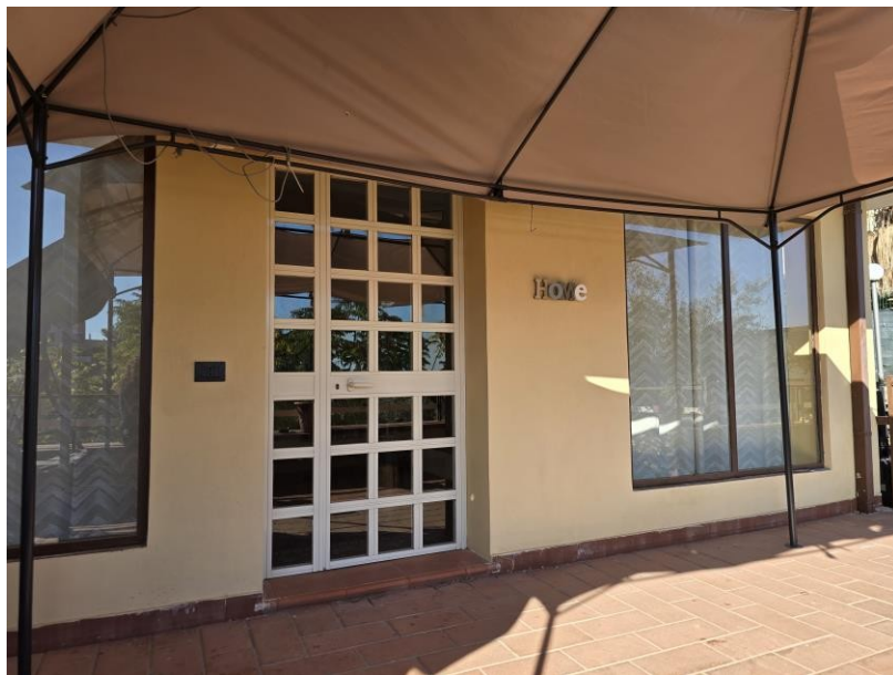
Foto n. 13 PIANO S1, primo sottostrada – portico di accesso all'appartamento
