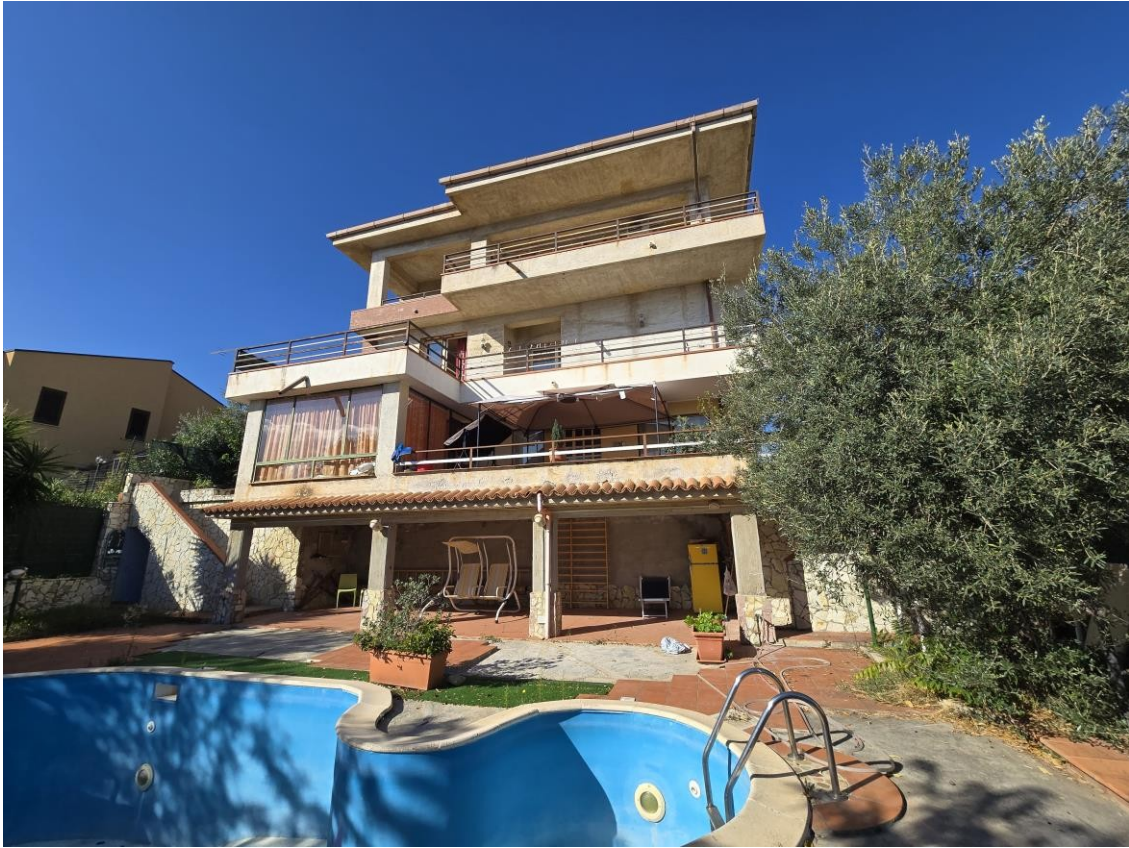
Foto n. 1 Vista del fronte est della villa (lato mare)
