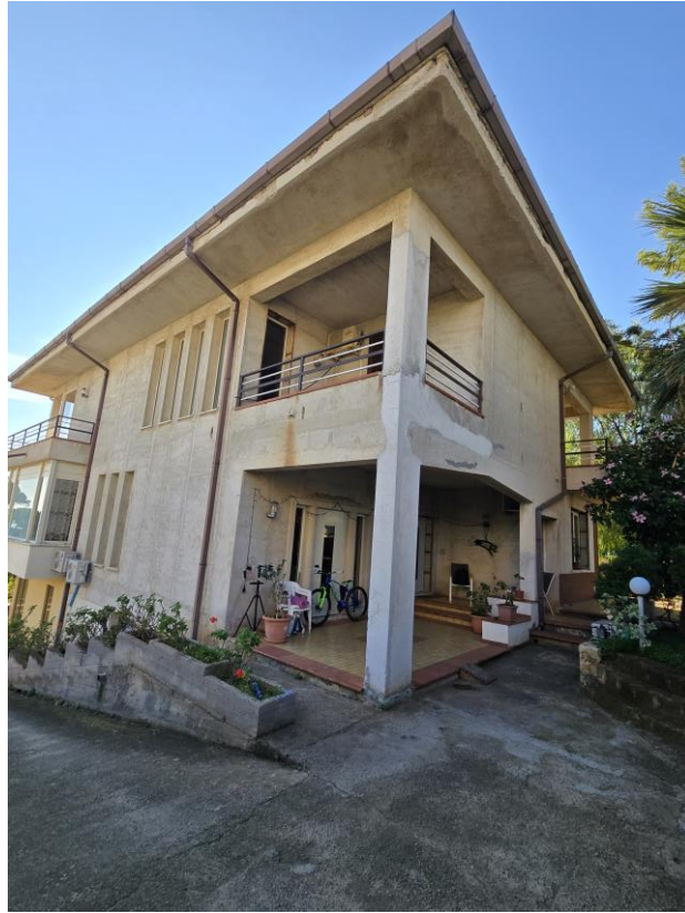
Foto n. 3 Vista fronte ovest e nord e dei piani terra e primo
