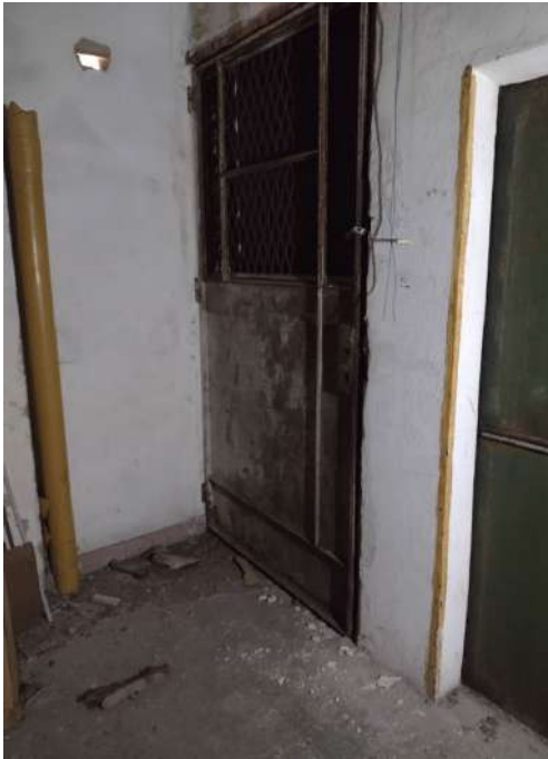
SCALA INTERNA AREA CONDOMINIALE AL LIVELLO 1° SOTTOSTRADA . PORTA CHIUSA CON LUCCHETTO
