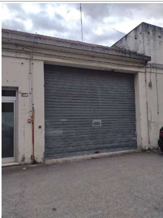
INGRESSO CARRABILE CONDOMINIALE LIVELLO STRADA P.TERRA VIA CAVALLOTTI
