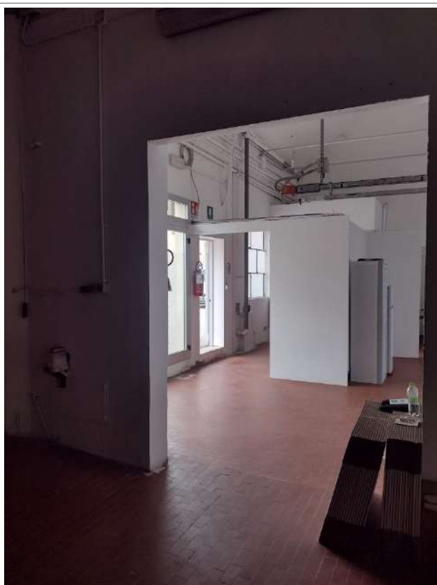
AREA CONDOMINIALE P.TERRA STRADA APERTA VERSO CONDOMINO
