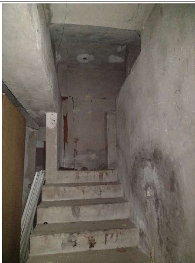
SCALA INTERNA ESCLUSIVA SUB 50 DAL PIANO IV AL PIANO III SOTTOSTRADA
