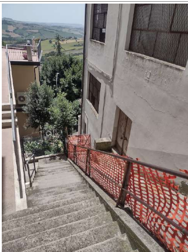
SCALA ESTERNA EST COLLEGAMENTO CON VIA MAGENTA
