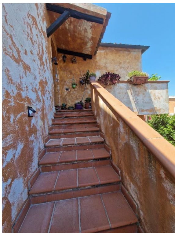
Scala di accesso al sub 6
