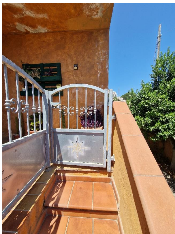
Cancello di accesso al sub 2
