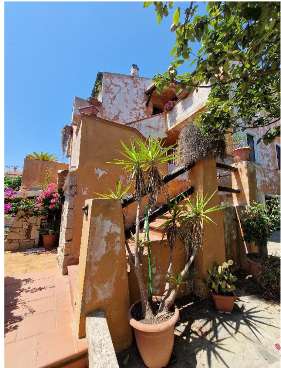
Scala di collegamento ai sub 5 e 6 (ex 3)
