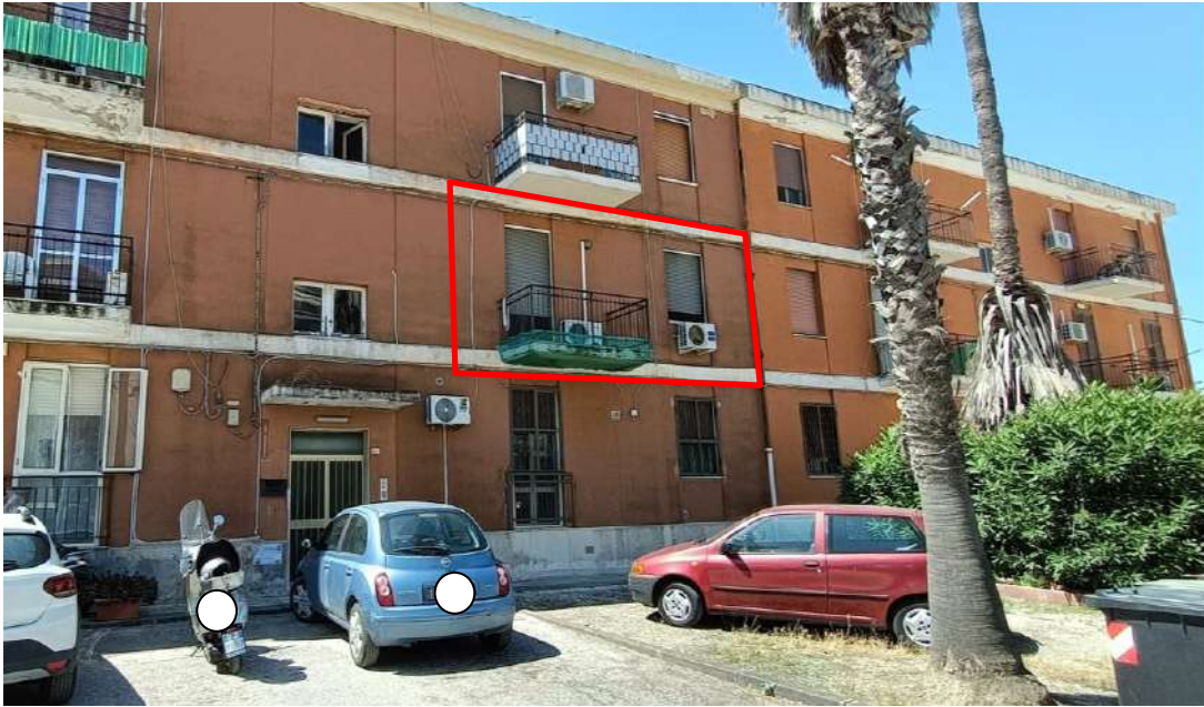
Foto 1. Vista esterna del complesso condominiale.
