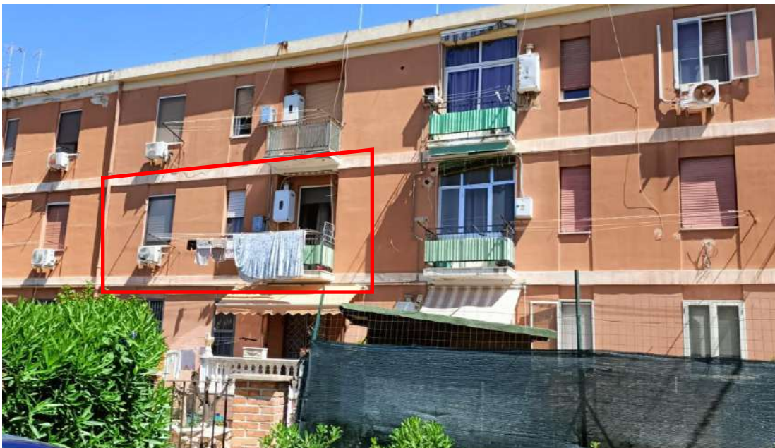
Foto 2. Vista dell'area condominiale della scala H.
