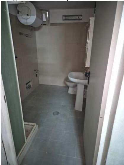
Figura 14 wc interno al box al piano seminterrato
