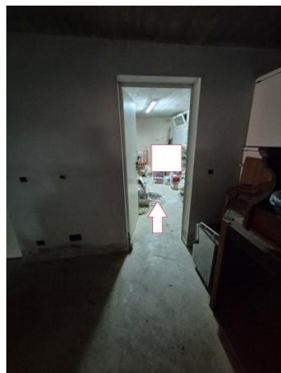
Figura 11 accesso al deposito annesso al box al piano seminterrato
