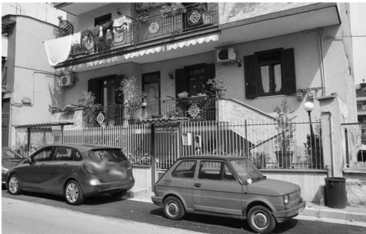
imm2.04: vista dalla strada
