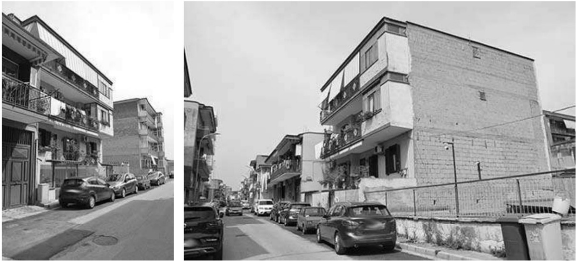
imm2.02: viste del fabbricato dalla strada
