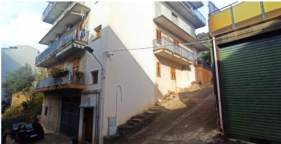
Foto n. 3 – Zona antistante l’edificio dove insiste l’immobile
