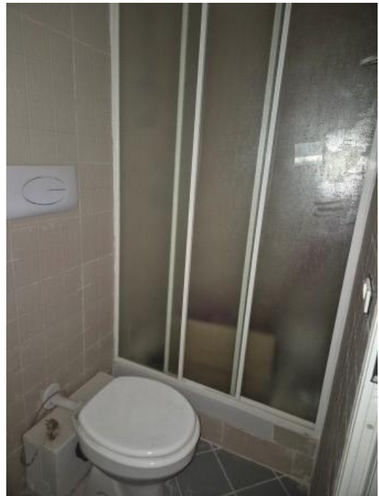
Figura 23 wc del deposito al piano seminterrato
