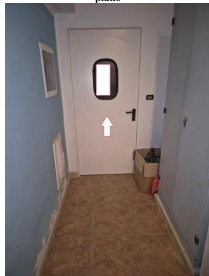
Figura 19 accesso al deposito con wc dal vano scala comune
