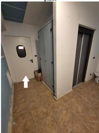
Figura 18 accesso al deposito con wc dal vano scala comune
