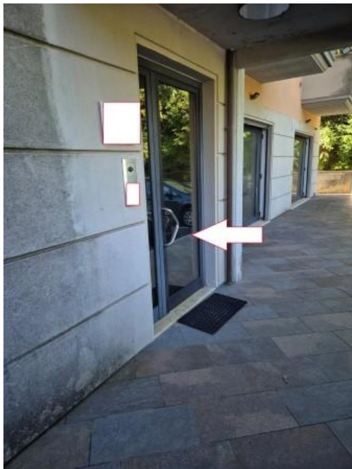
Figura 6 accesso al vano scala comune del fabbricato
