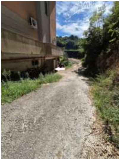
Figura 5 rampa carrabile per accesso al piano seminterrato in corso di costruzione
