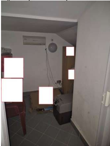
Figura 11 deposito con wc al piano seminterrato
