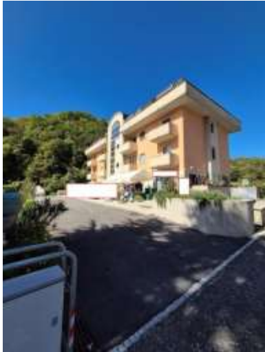
Figura 1 facciata sud/est del fabbricato a cui appartiene l'immobile pignorato in Pratella alla via Ravone n.1
