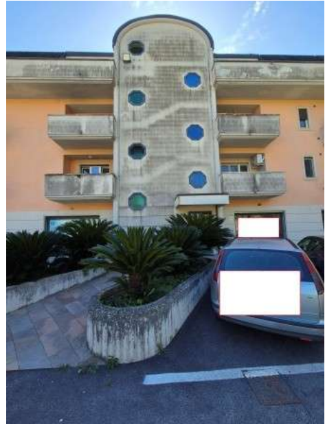
Figura 2 facciata nord del fabbricato a cui appartiene l'immobile pignorato in Pratella alla via Ravone n.1
