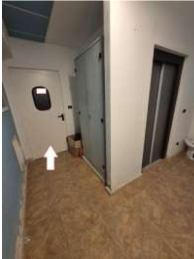
Figura 7 accesso al deposito con wc dal vano scala comune
