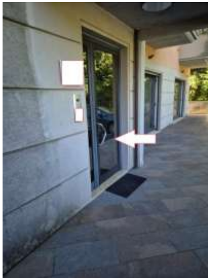
Figura 3 accesso al vano scala comune del fabbricato
