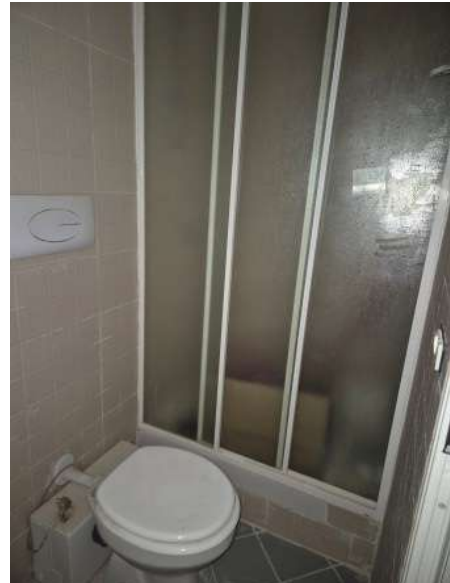
Figura 12 wc del deposito al piano seminterrato
