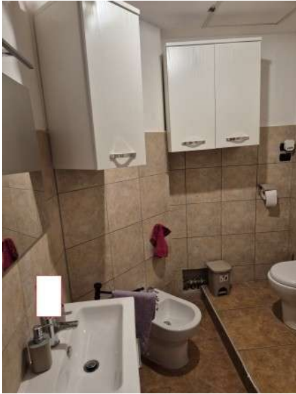
Figura 13 bagno dell'appartamento pignorato al secondo piano
