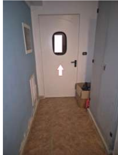
Figura 8 accesso al deposito con wc dal vano scala comune
