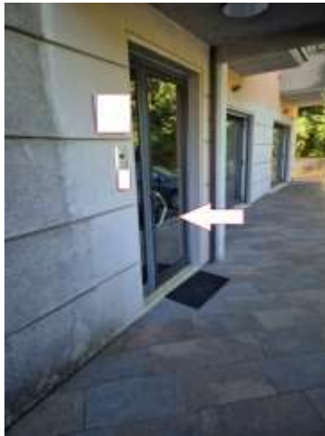
Figura 3 accesso al vano scala comune del fabbricato
