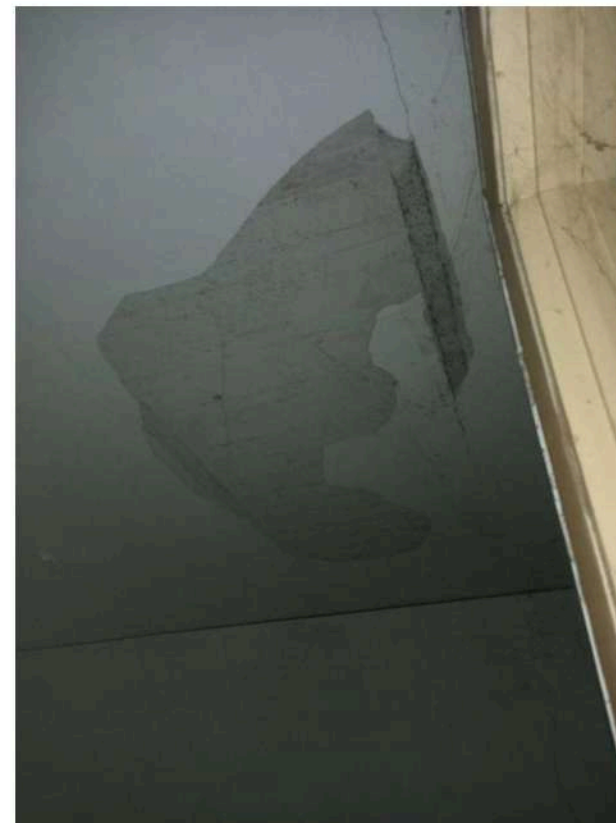
FOTOGRAFIE 33-34: viste della prima camera al piano primo, con scrostamento di intonaco sul soffitto.
