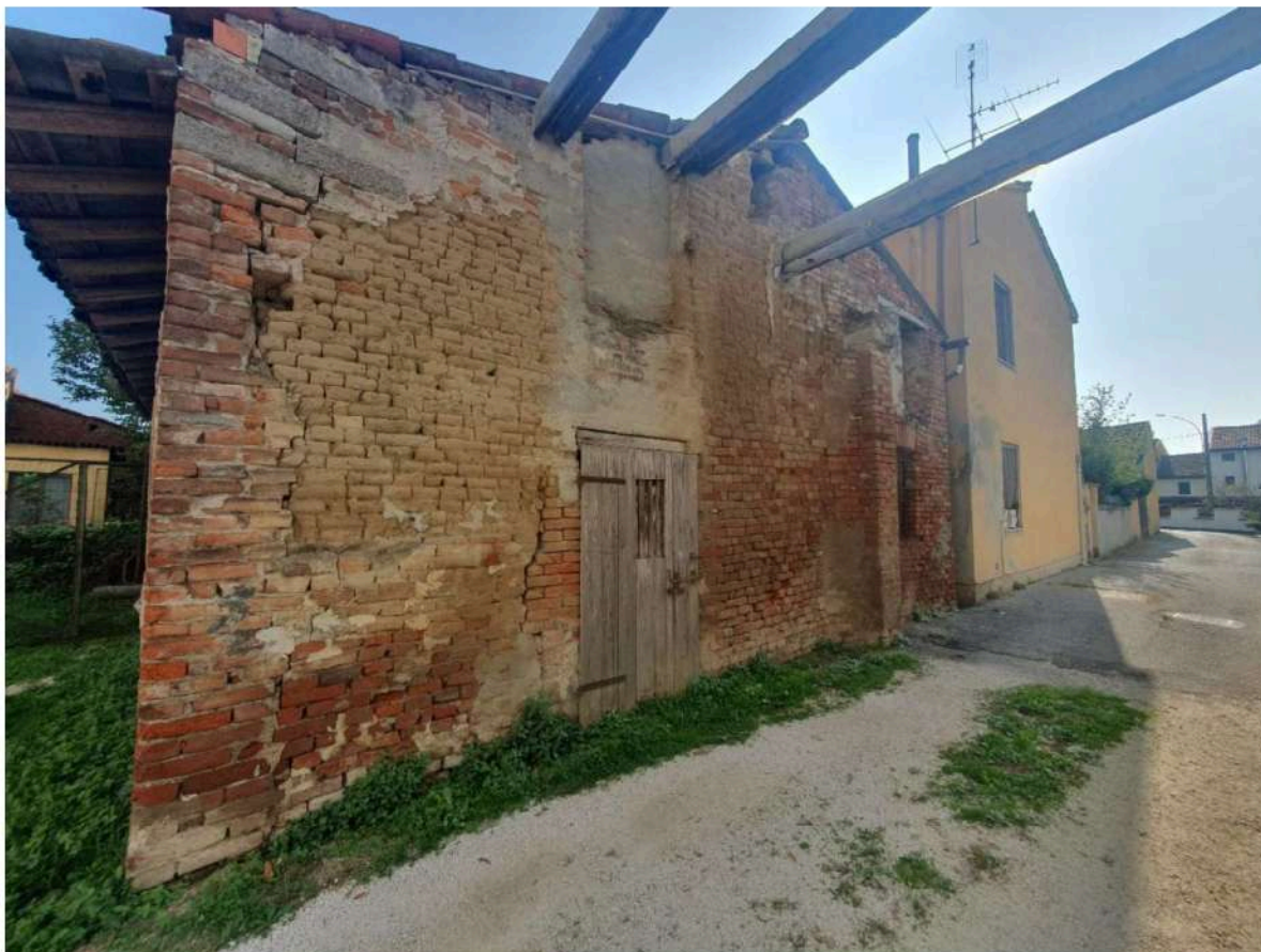
FOTOGRAFIA 5: vista dei fabbricati accessori (portici e cantine). Il portico di ingresso è stato fatto demolire.
