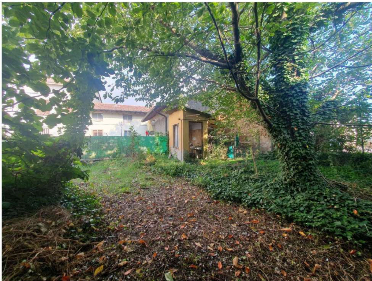
FOTOGRAFIA 17: fotografia complessiva dell'area comune di accesso principale, vista dal cortile comune.
