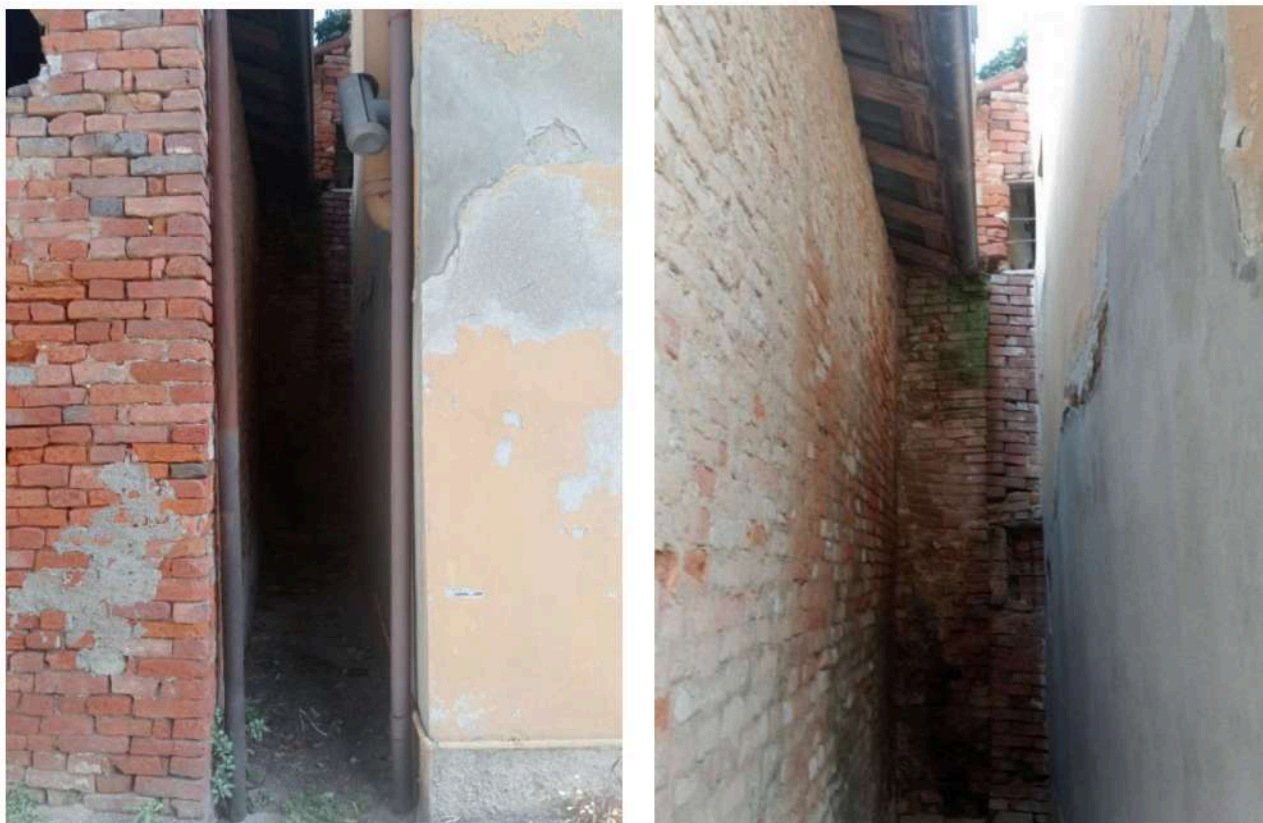
FOTOGRAFIE 14-15: viste di un cavedio di separazione tra i fabbricati accessori e un'altra proprietà.
