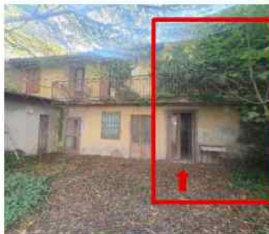
Vista dell'ingresso principale dal Cortile Nord
