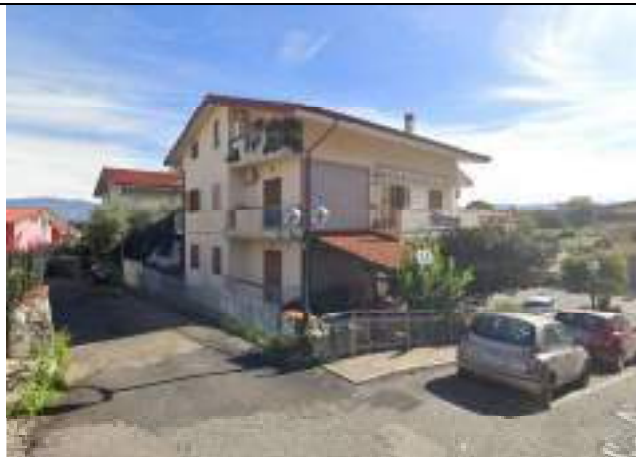
Vista dello stabile da [redacted] – fronte OVEST
