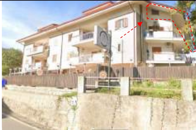
Vista dello stabile da [redacted] i – fronte SUD
