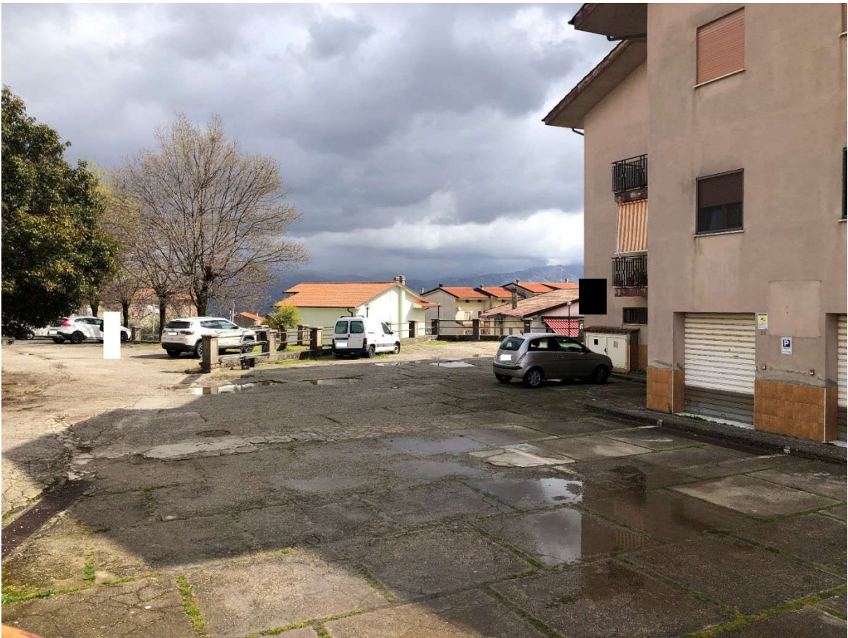
Foto 5 - Fabbricato in Marano Marchesato, Via Morroni n.33, corte esterna.
