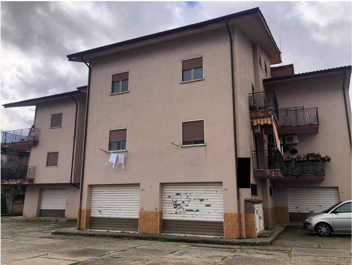
Foto 3 - Fabbricato in Marano Marchesato, Via Morroni n.33.
