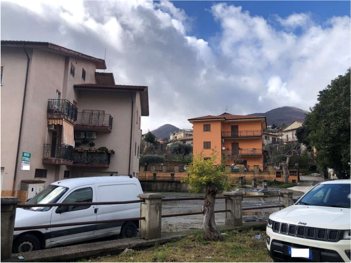
Foto 7 - Fabbricato in Marano Marchesato, Via Morroni n.33, corte esterna.
