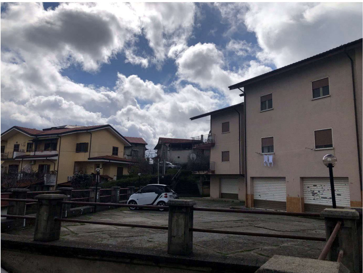
Foto 6 - Fabbricato in Marano Marchesato, Via Morroni n.33, corte esterna.
