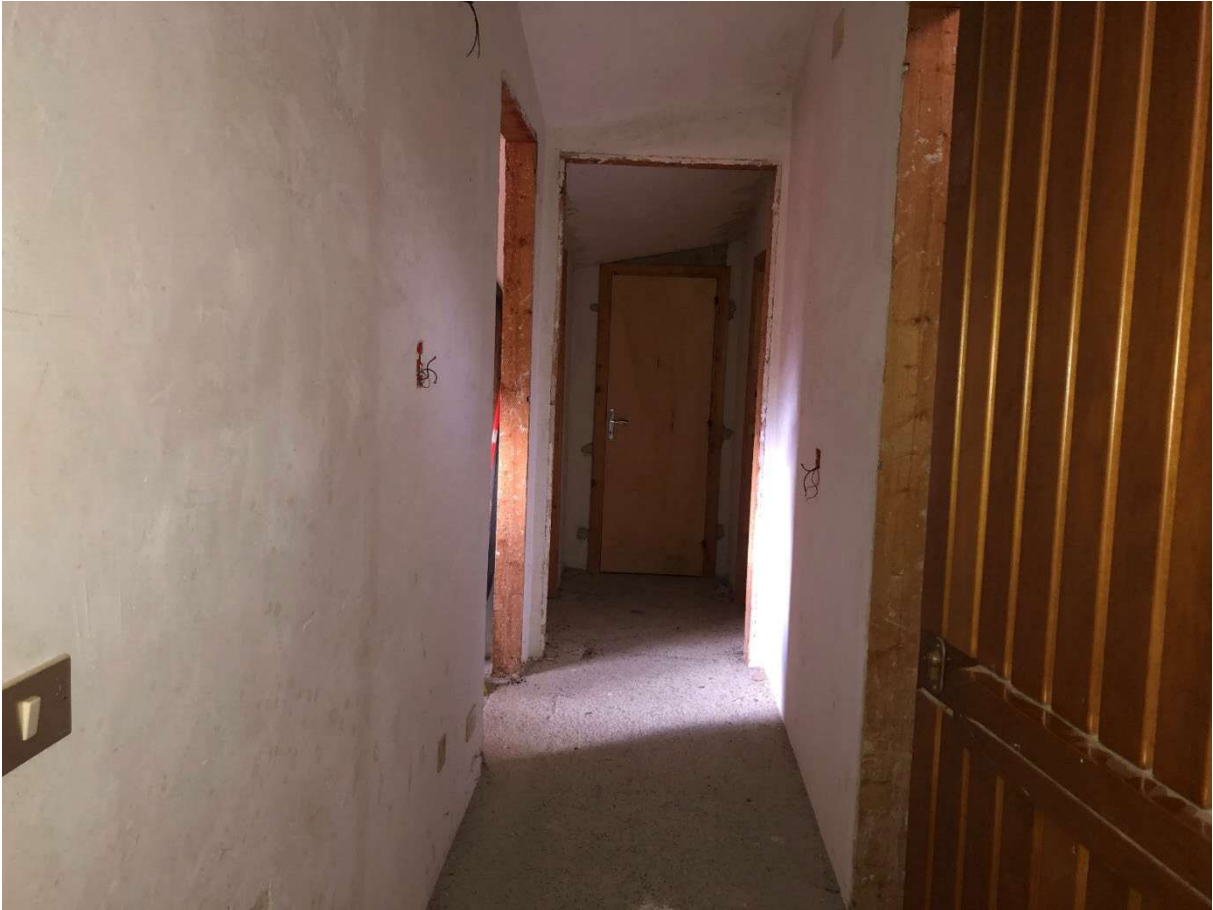
Foto 29 - Corridoio soffitte al piano terso/sottotetto.
