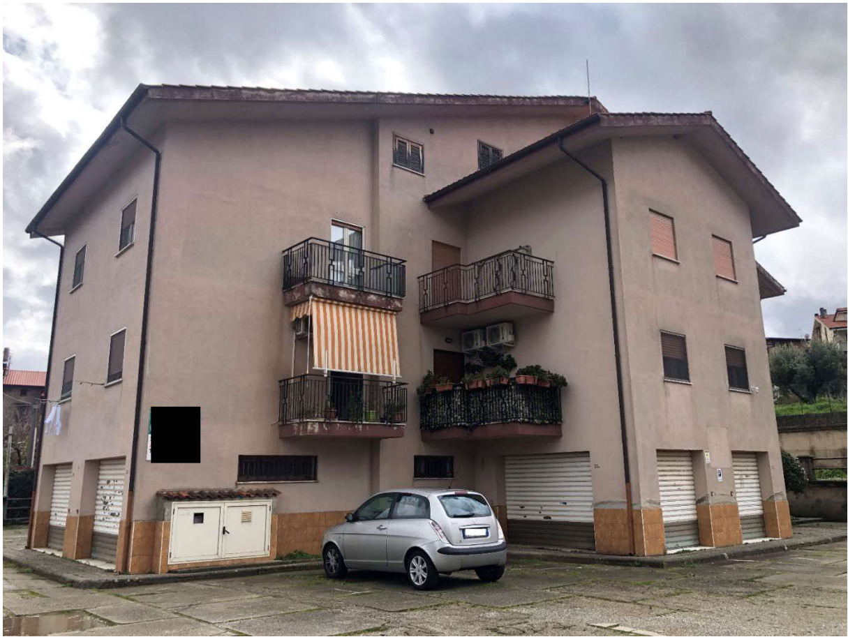
Foto 1 - Fabbricato in Marano Marchesato, Via Morroni n.33.
