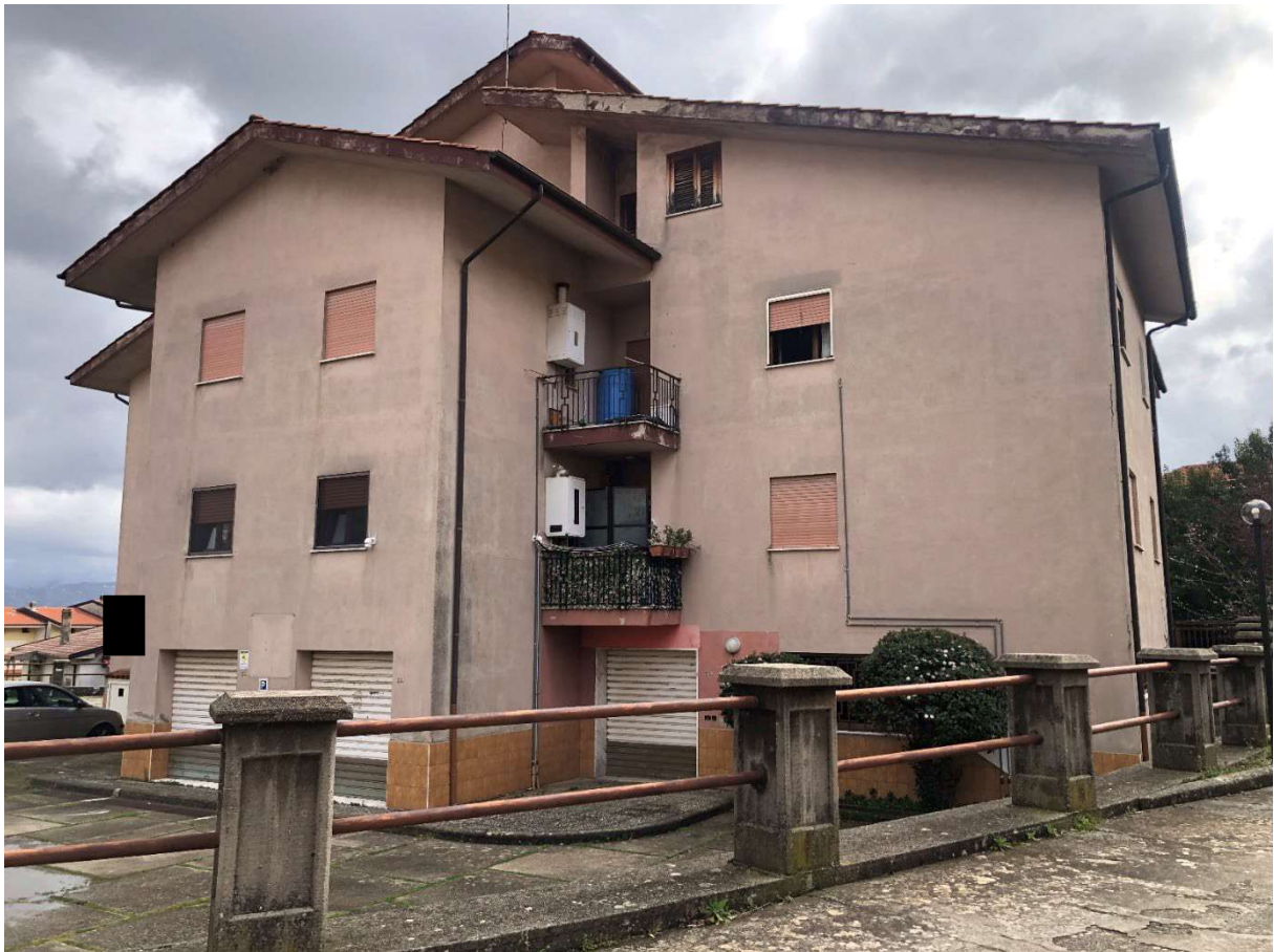
Foto 2 - Fabbricato in Marano Marchesato, Via Morroni n.33.
