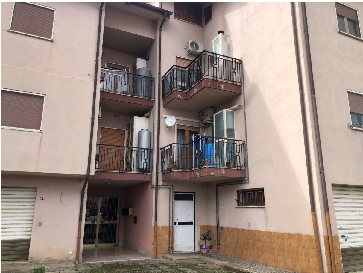
Foto 4 - Fabbricato in Marano Marchesato, Via Morroni n.33, ingresso.
