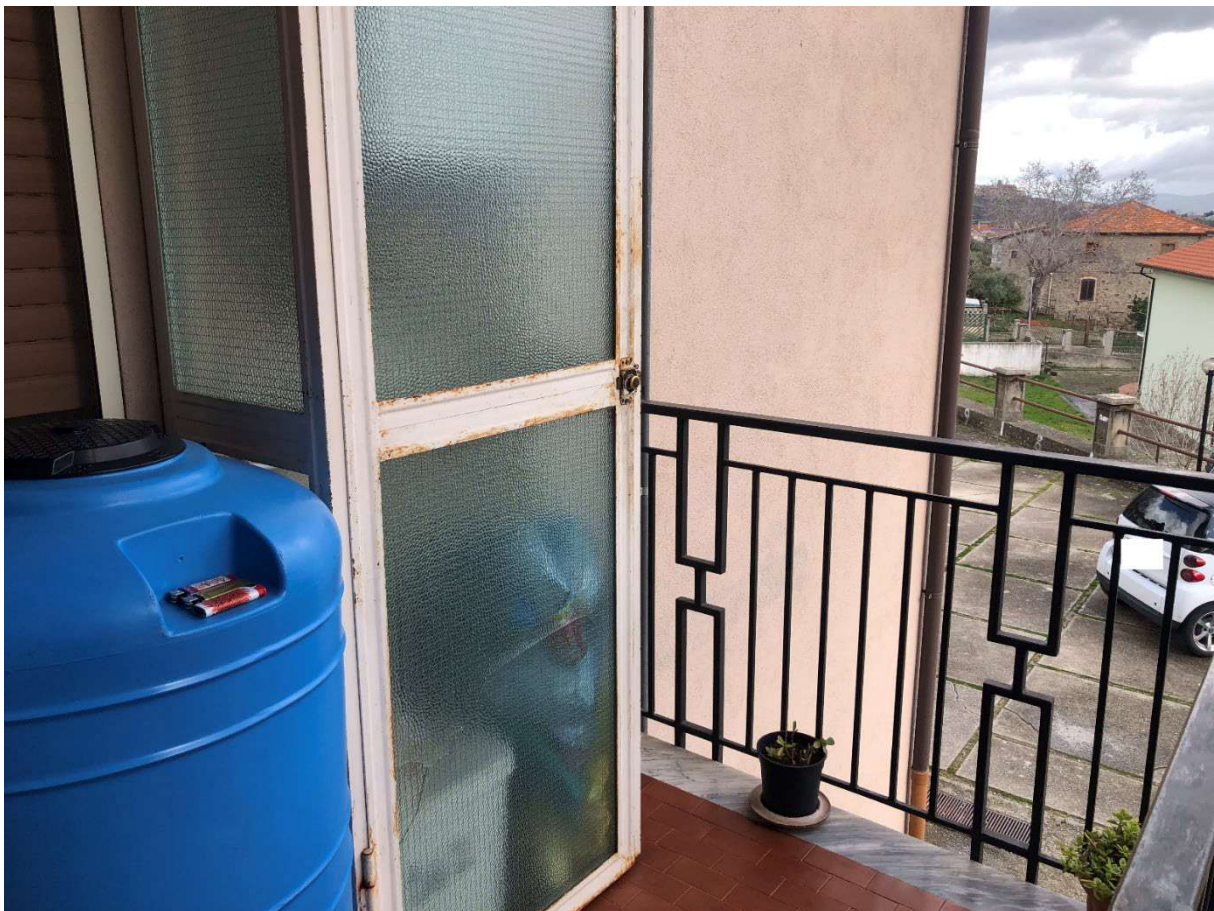
Foto 28 - Appartamento piano primo, balcone zona giorno con box caldaia.
