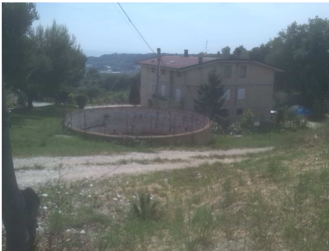
Foto n. 13 (vasca a cielo aperto)
