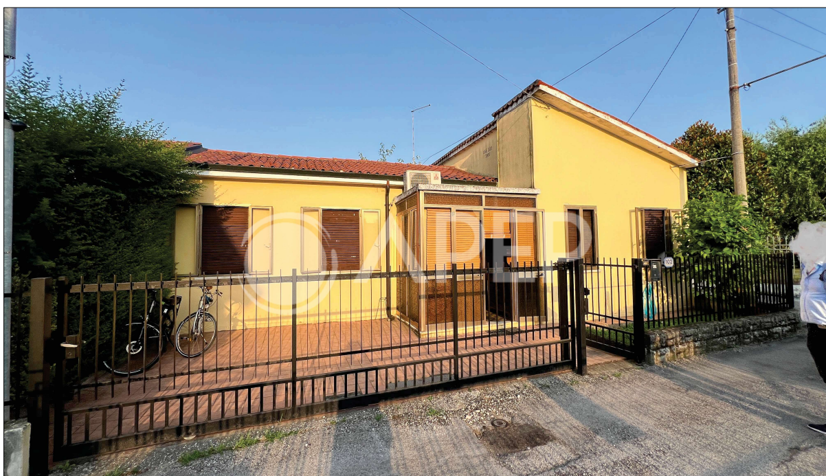
Vista del fabbricato da Ovest – Via degli Arditi
