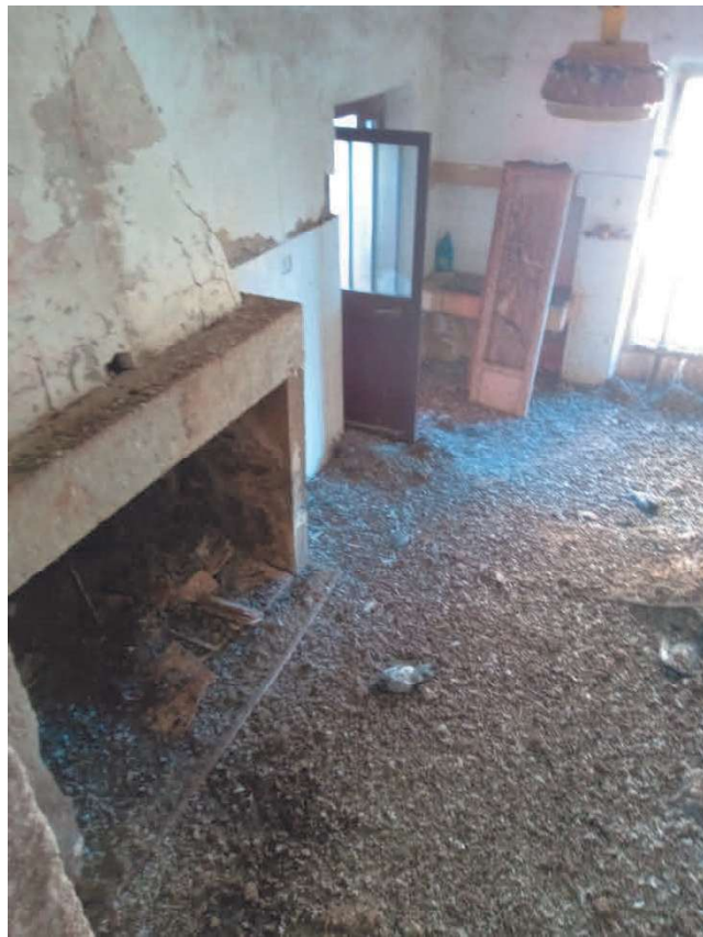
VANO EX TINELLO PIANO TERRA
