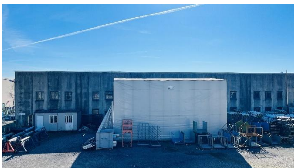
Edificio C – Magazzino tessuti
