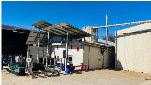
Edificio B – Autorimessa / officina
