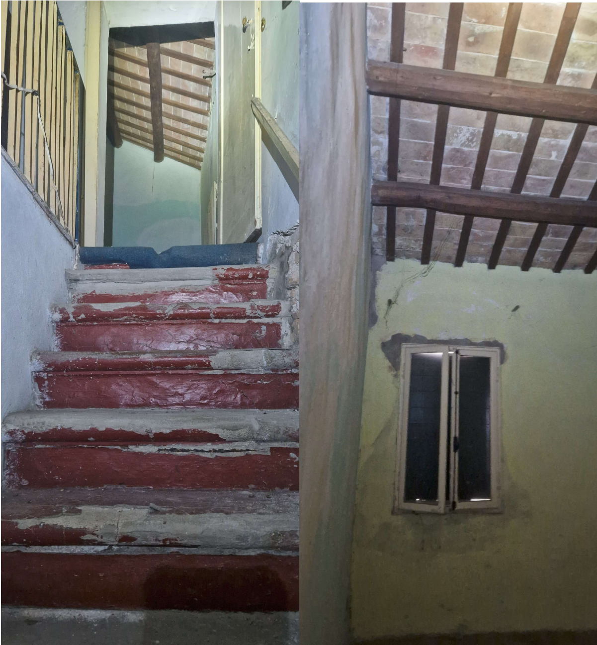
Scale e interno piano primo particolare del tetto e infissi
