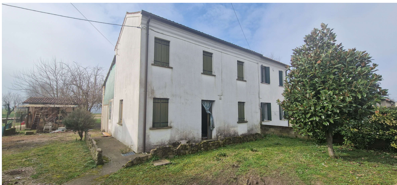
Vista dal cancello di entrata
