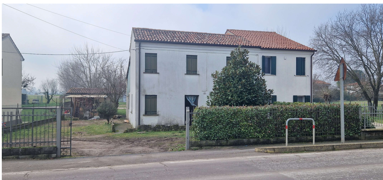
Vista dalla strada con accesso
