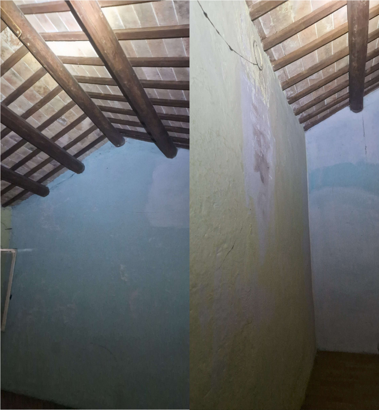
Particolari interni del tetto piano superiore
