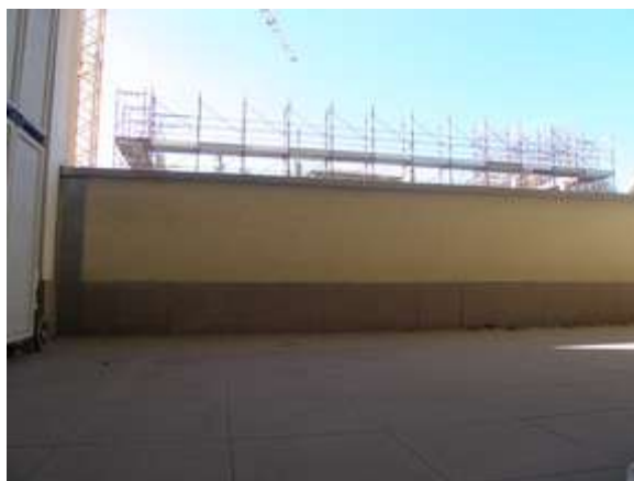
Vista balcone su fronte interno
