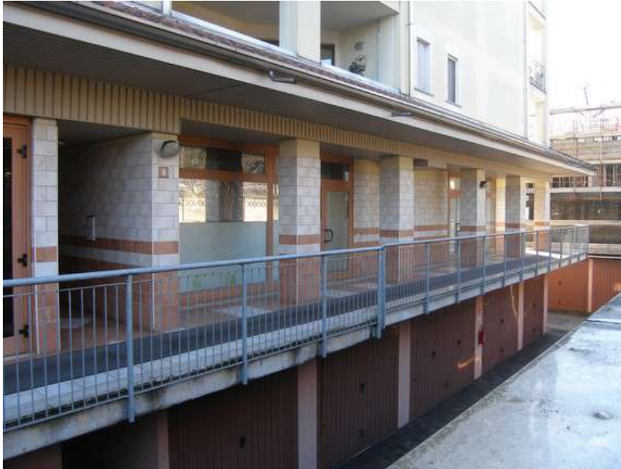
Vista ballatoio di accesso alle scale con sottostanti box auto
