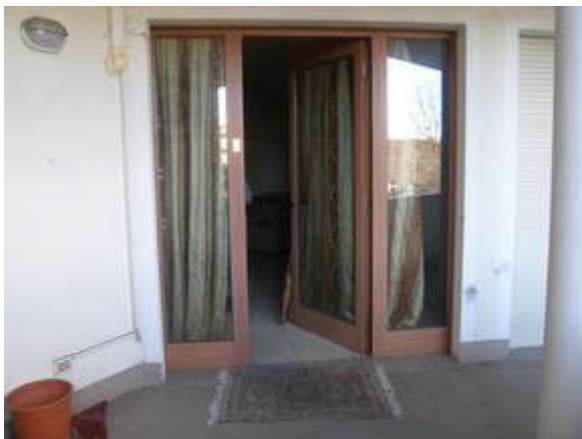
Vista porta di ingresso al subalterno da balcone 1
