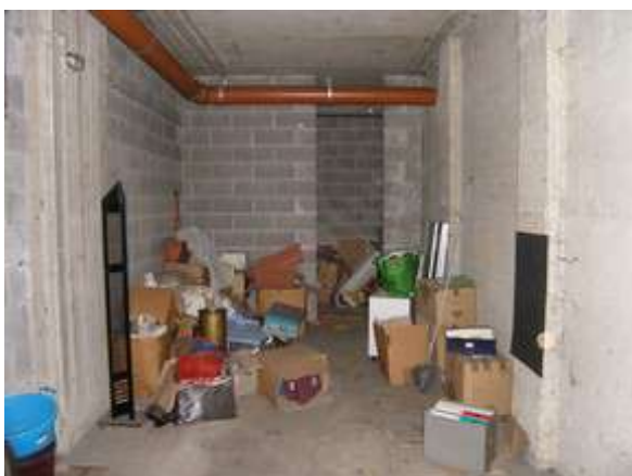
Vista box e vano cantina
