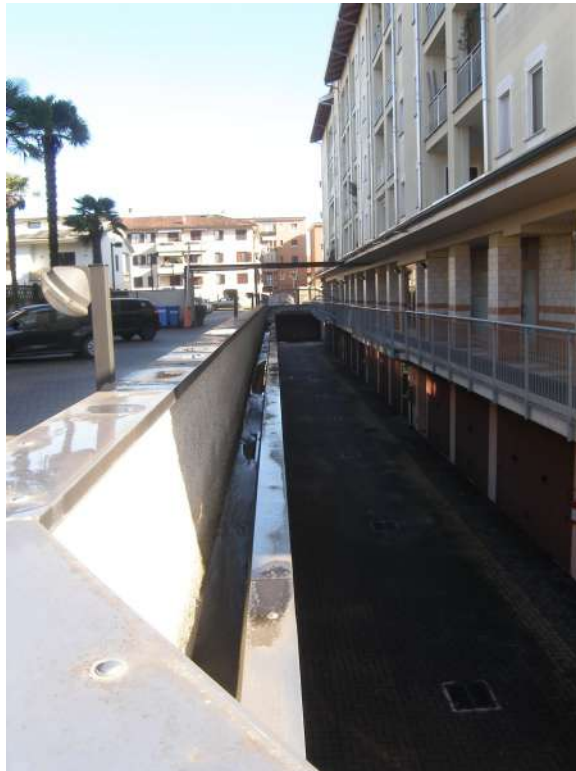
Vista ballatoio di accesso alle scale con sottostanti box auto
