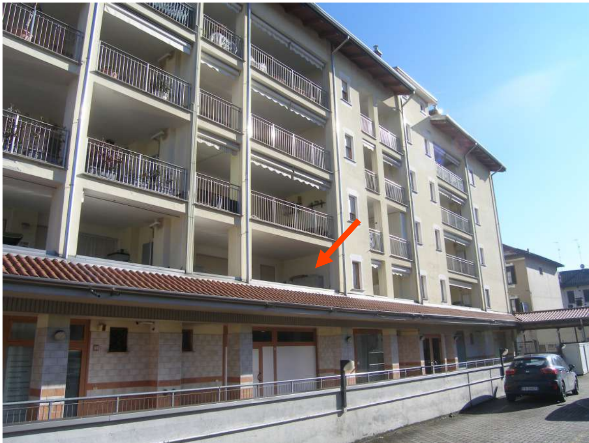
Vista fronte posteriore con identificazione subalterno
