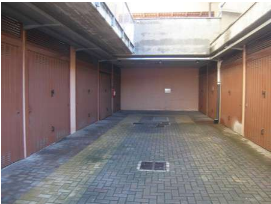
Vista corsello box auto
