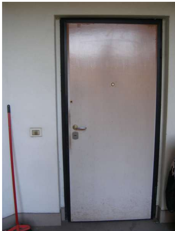
Vista porta accesso da scala comune su balcone 1
