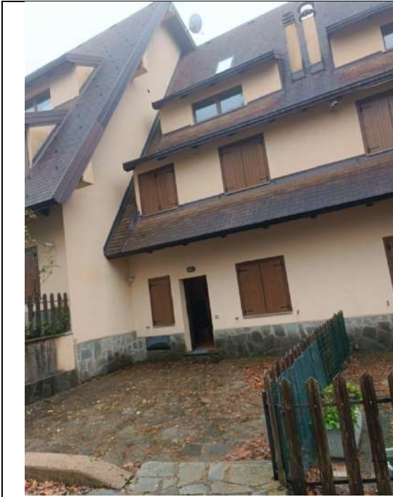
Foto 3. Vista esterna del fabbricato, prospetto principale Nord
