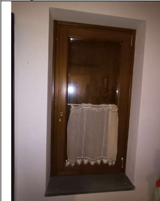
Foto 37. Particolare della tipologia di finestra interna ad una anta, in legno, vetro doppio
