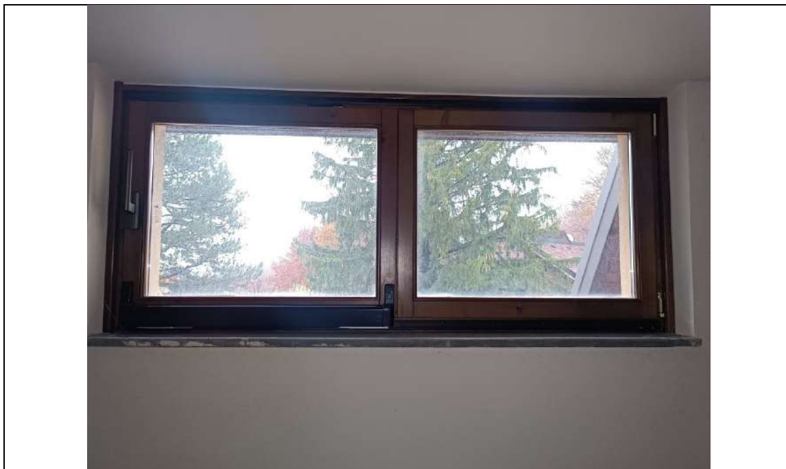
Foto 39. Particolare della tipologia di finestra interna a due ante scorrevoli, in legno, vetro doppio senza scuretti esterni presente al piano secondo
