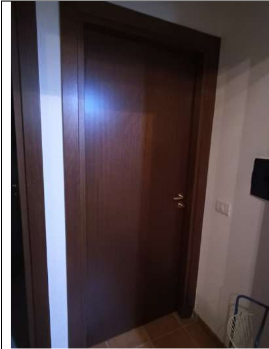
Foto 35. Particolare della tipologia di porta interna, in legno tamburato all'interno dell'abitazione
