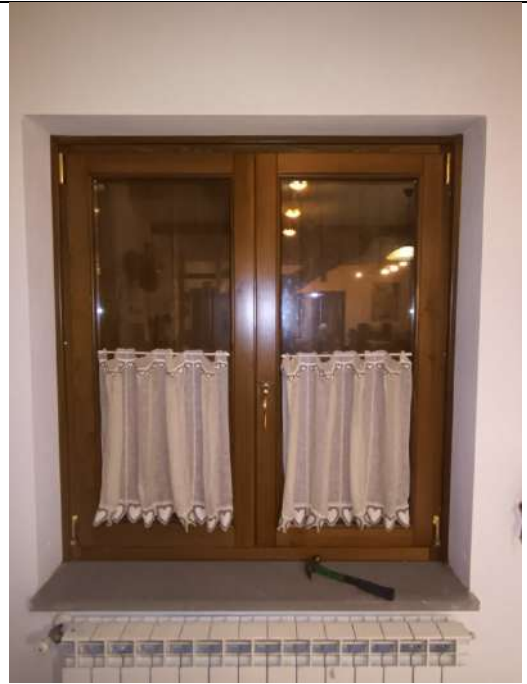
Foto 36. Particolare della tipologia di finestra interna a due ante, in legno, vetro doppio
