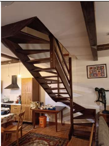
Foto 10. Particolare della tipologia costruttiva in legno della scala interna all'abitazione
