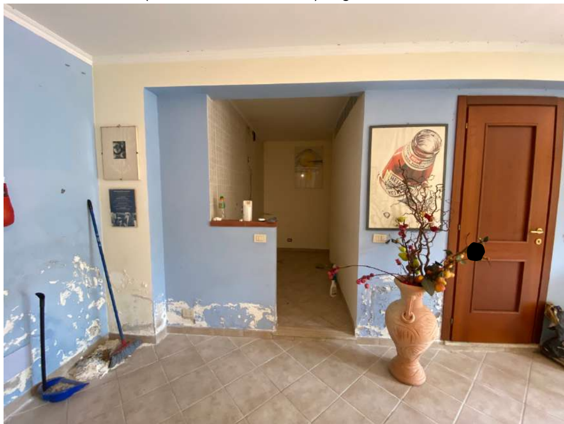
Piano seminterrato (nello stato di fatto terra) angolo cottura – foto n. 10
